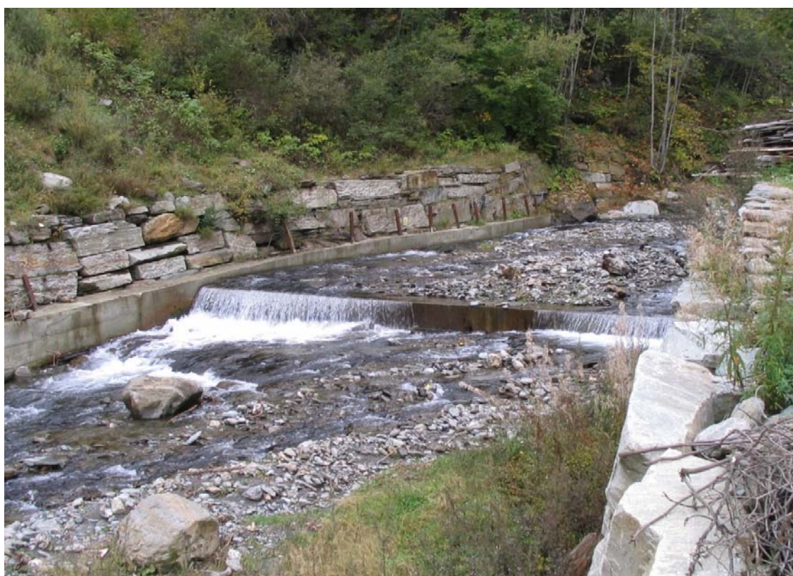
Foto 002 – Opera PENNSO002 vista da valle, sponda sinistra del T. Germanasca.
