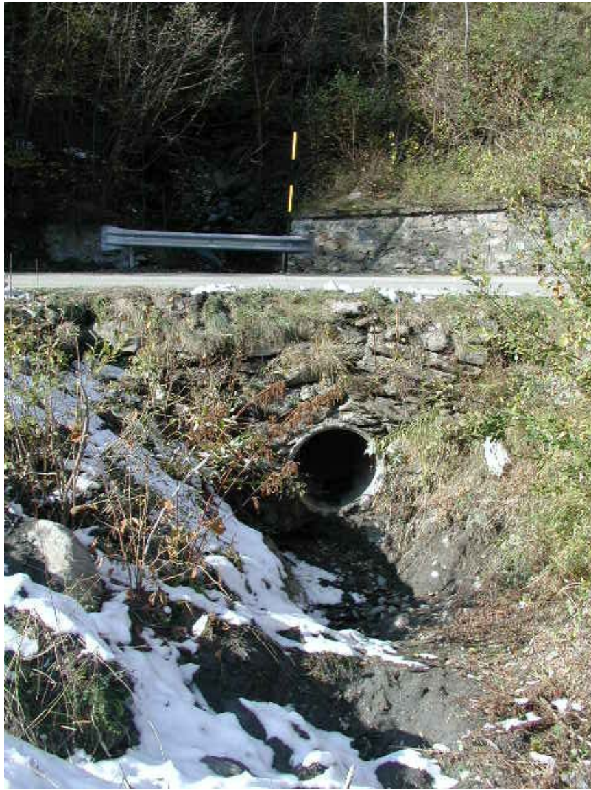
Foto 003 – Opera CANAAG003 . Ripresa da valle dell'opera.
