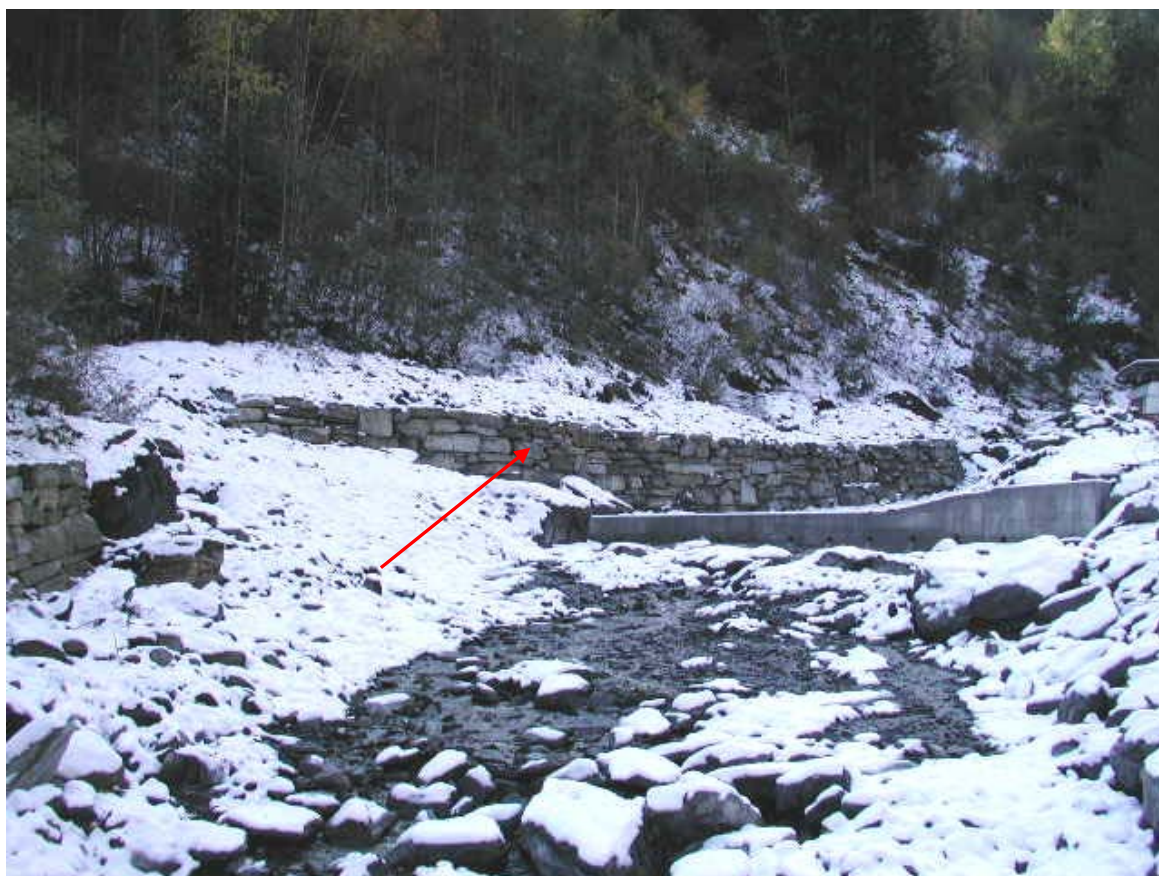
Foto 004 – Opera CANADS004 . Dal ponte BATTPO002 , verso monte.
