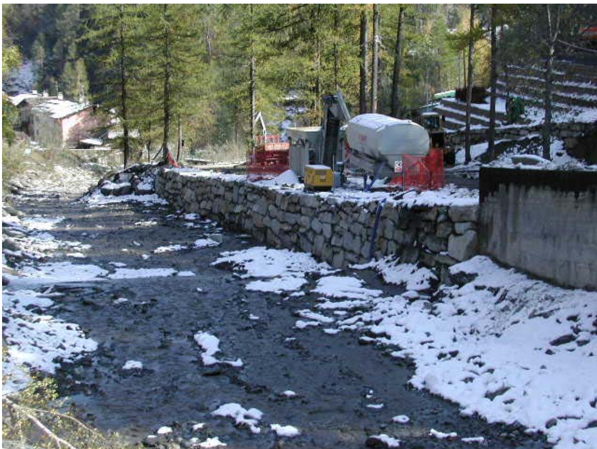
Foto 007 – Opera BATTDS007 . Ripresa da monte, dal ponte BATTPO002.
