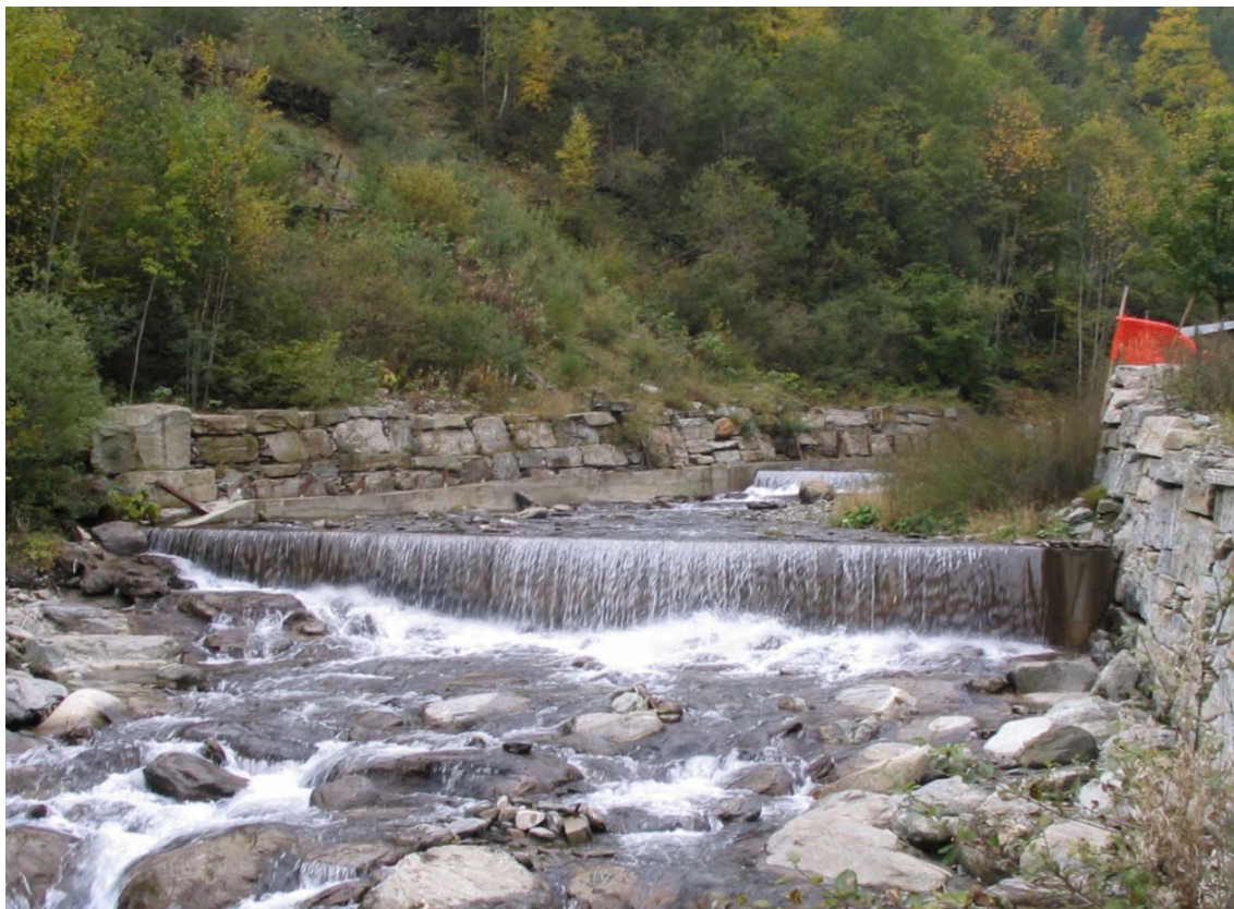
Foto 001 – Opera PENNSO001 vista da valle, sponda sinistra del T. Germanasca.
