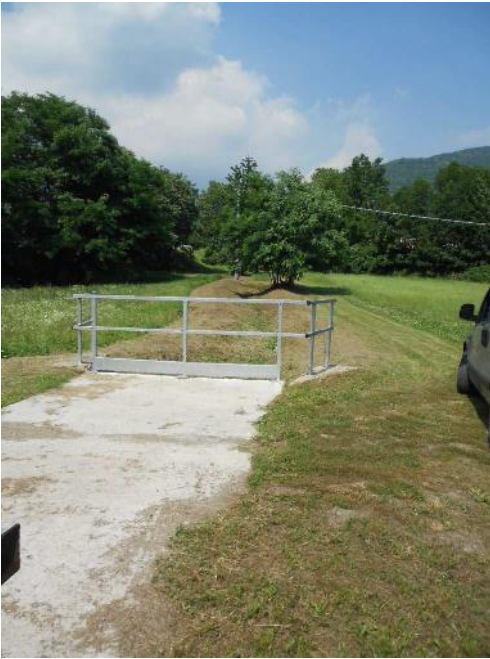
Foto 019 – Opera CASTCA022 . Ripresa dell'opera, a valle della sezione di imbocco.
