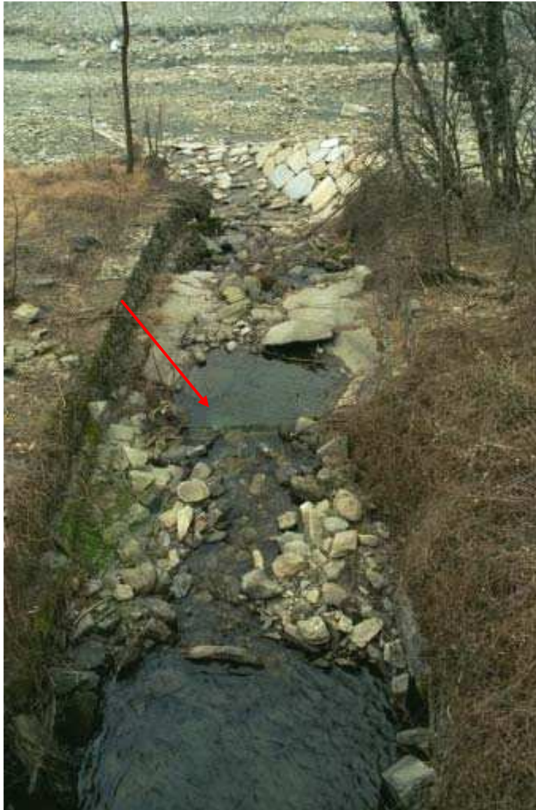
Foto 005 – Opera CANASO005 . Ripresa da monte, dal ponte TREVPO002 .
