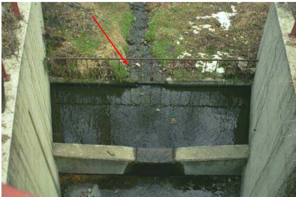
Foto 001 – Opera CANABR001 . Ripresa da valle verso monte.
