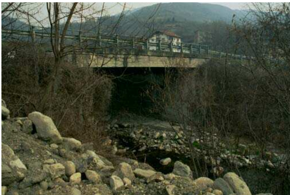
Foto 003 – Opera CANAPO003 . Ripresa da valle verso monte.
