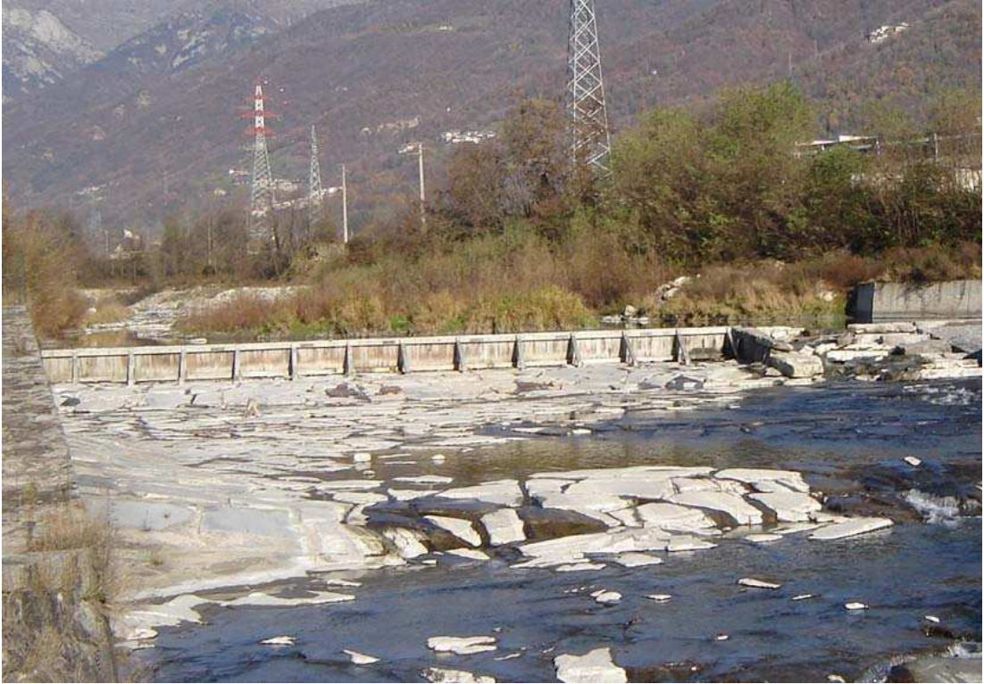
Foto 019 – Opera BATTSO019 . Ripresa da valle, sponda destra del T.Chisone.
