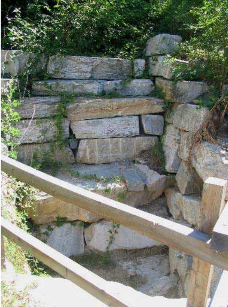
Foto 21 – Opera BATTSO021 . Ripresa frontale dalla strada, in corrispondenza dell'imbocco del tratto intubato PENNCA018.
