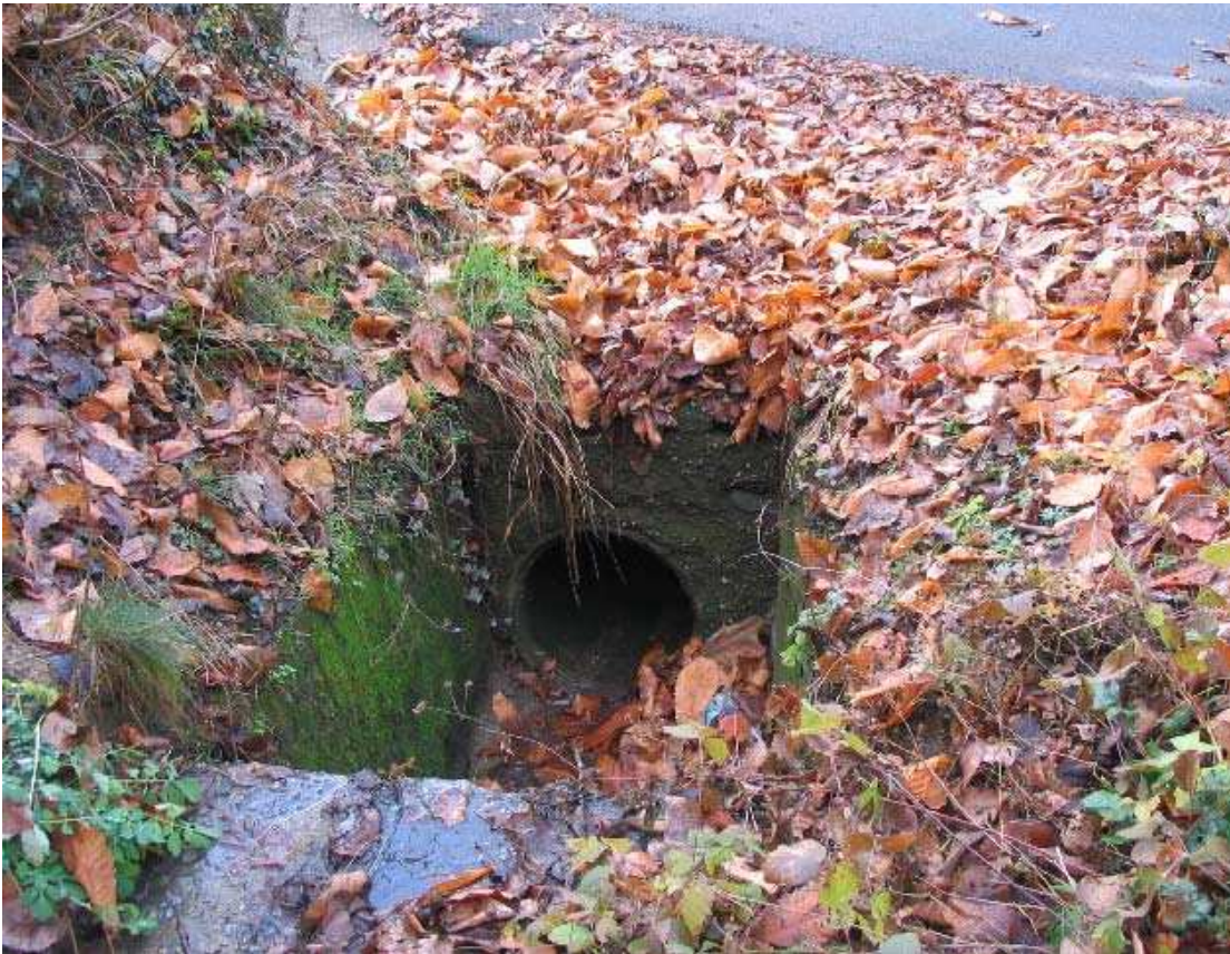
Foto 015 – Opera BATTCA016 . Ripresa da monte, sponda destra del rio.
