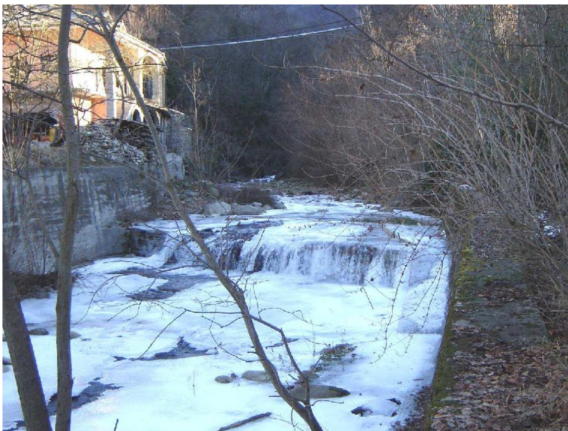
Foto 014 – Opera TREVS0014 . Ripresa da valle verso monte.
