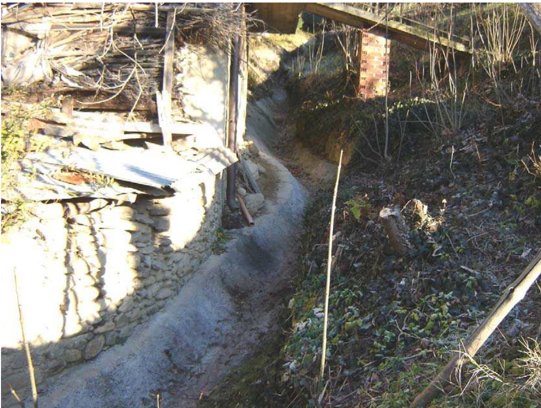
Foto 016 – Opera BATTCA017 . Ripresa da valle, sponda sinistra dell'impluvio.
