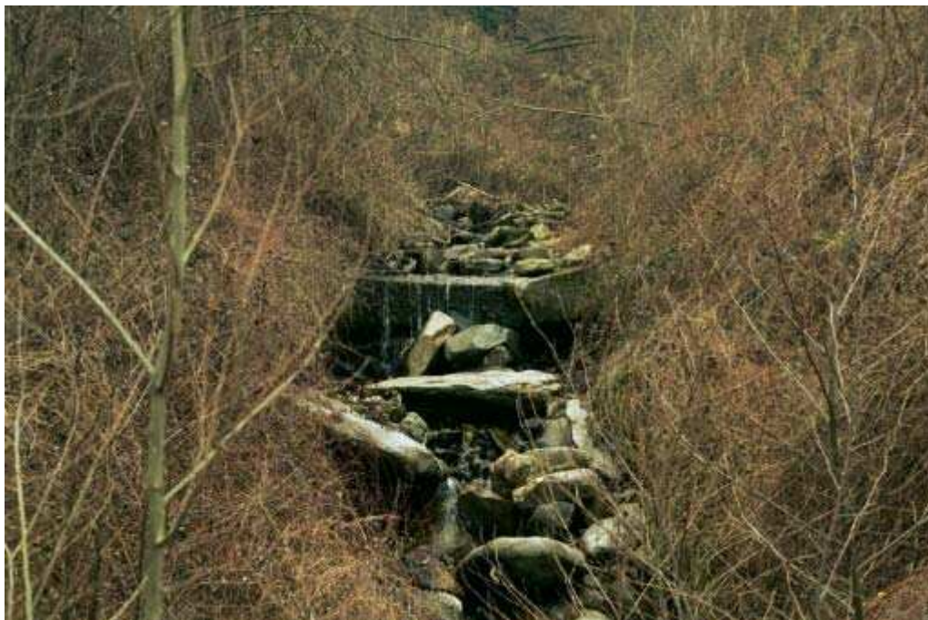
Foto 007 – Opera CANASO007 . Ripresa da valle verso monte.
