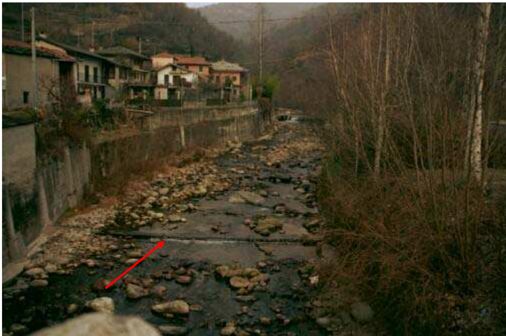
Foto 015 – Opera CANASO015 . Ripresa da valle verso monte.
