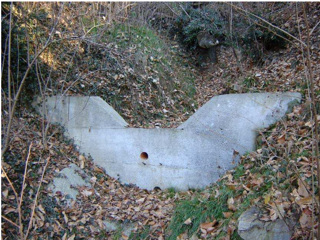
Foto 014 – Opera BATTBR014 . Ripresa da valle, sponda sinistra dell'impluvio.
