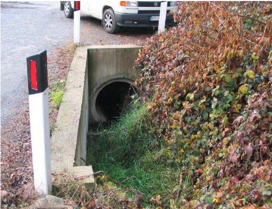
Foto 013 – Opera BATTCA014 . Ripresa da monte, sponda sinistra del rio.
