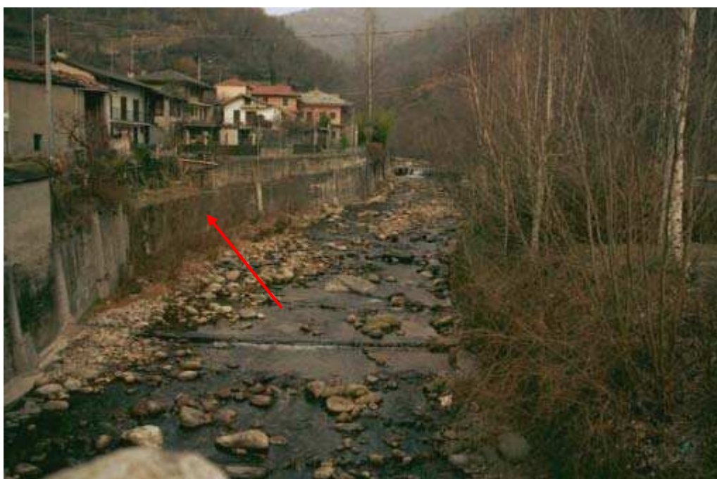
Foto 009 – Opera CANADS009 . Ripresa da valle verso monte.
