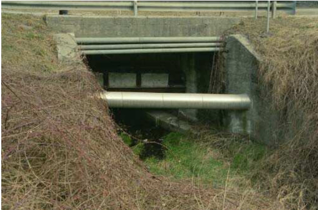
Foto 004 – Opera TREVAG004 . Ripresa da valle verso monte.
