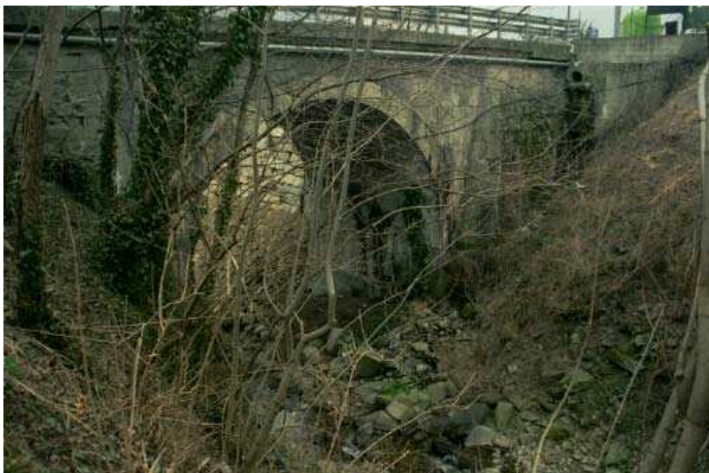
Foto 001 – Opera CANAPO001 . Ripresa da valle verso monte.
