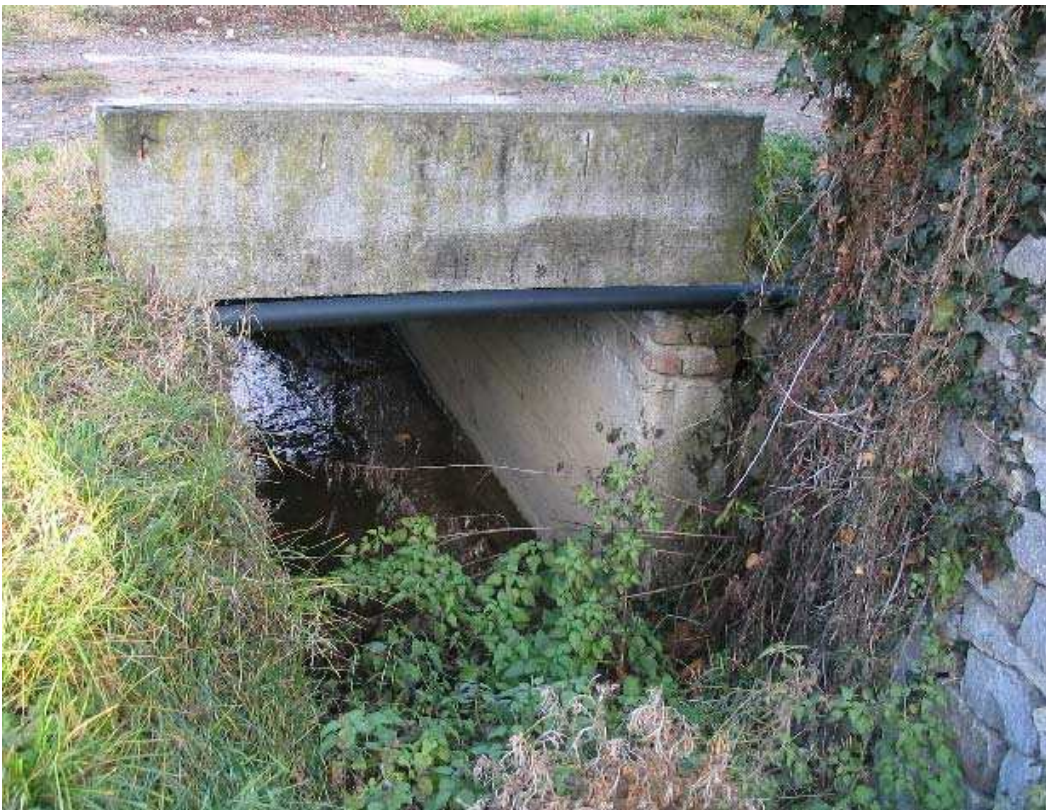
Foto 002 – Opera TREVAG002 . Ripresa da valle, sponda destra del rio.
