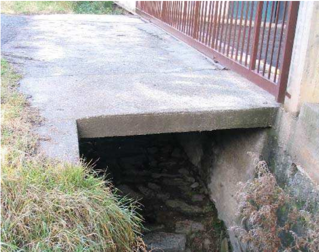
Foto 001 – Opera CANAAG001 . Ripresa da valle, sponda destra del rio.
