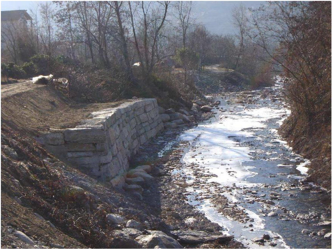
Foto 016 – Opera BATTDS017 . Ripresa da valle, dal ponte CANAPO003.
