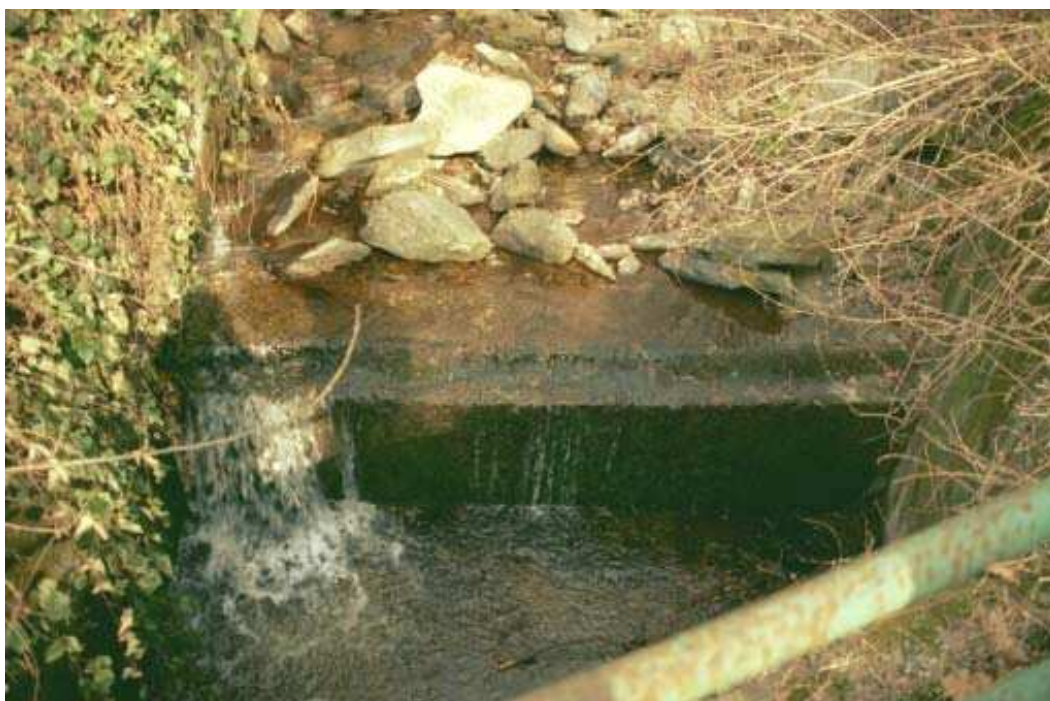
Foto 018 – Opera TREVS0018 . Ripresa da valle verso monte.
