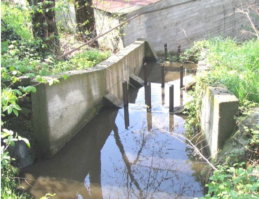
Foto 011 – Opera PENNBR011 . Ripresa da monte, dall'alveo dell'impluvio.
