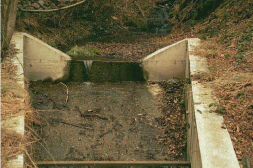
Foto 009 – Opera CANABR009 . Ripresa da valle verso monte.
