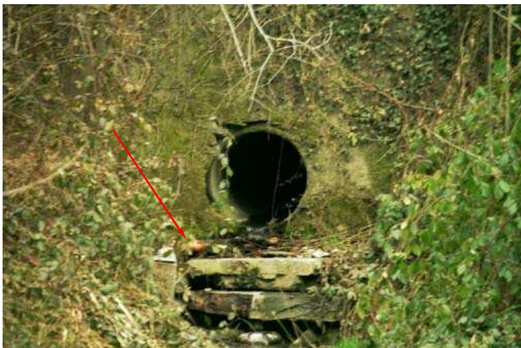
Foto 009 – Opera CANASO009 . Ripresa da valle verso monte.
