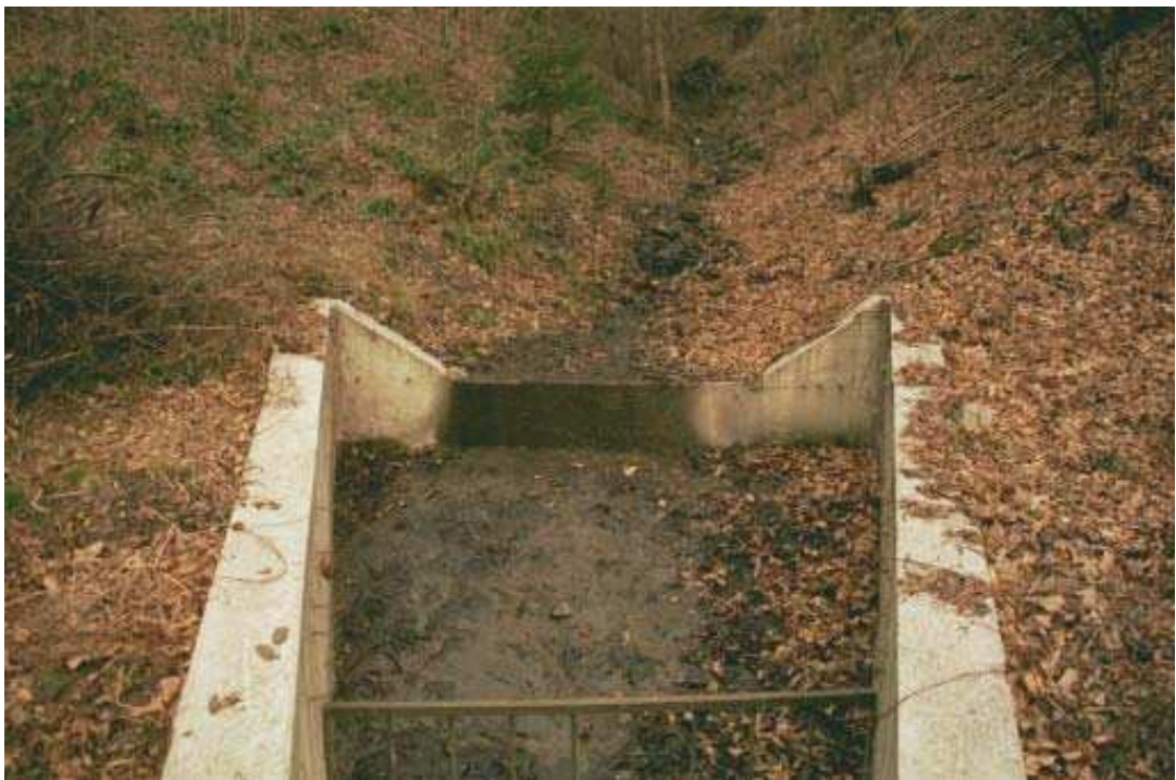
Foto 008 – Opera TREVBR008 . Ripresa da valle verso monte.
