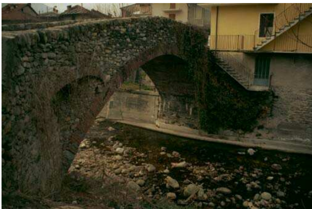
Foto 004 – Opera TREVPO004 . Ripresa da monte verso valle.
