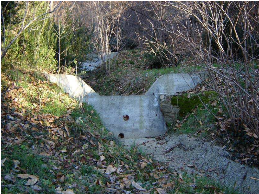
Foto 012 – Opera BATTBR012 . Ripresa da valle, sponda destra dell'impluvio.
