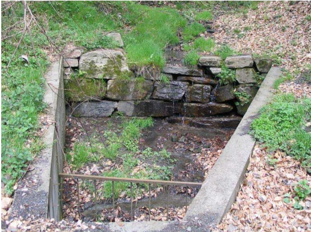
Foto 011 – Opera CANASO011 . Ripresa da valle verso monte.
