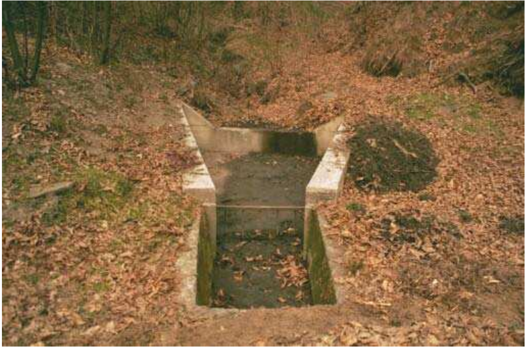
Foto 007 – Opera CANABR007 . Ripresa da valle verso monte.
