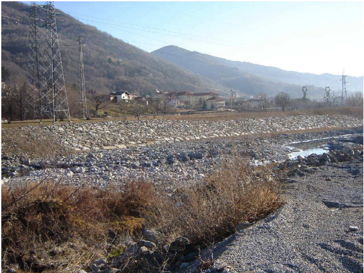
Foto 012 – Opera PENNDS012 . Ripresa di fronte, sponda destra del T. Chisone.
