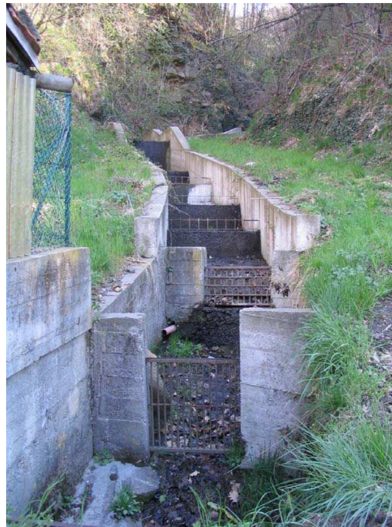
Foto 006 – Opera PENNA006 . Ripresa frontale da valle, dalla canalizzazione BATTCA007 .
