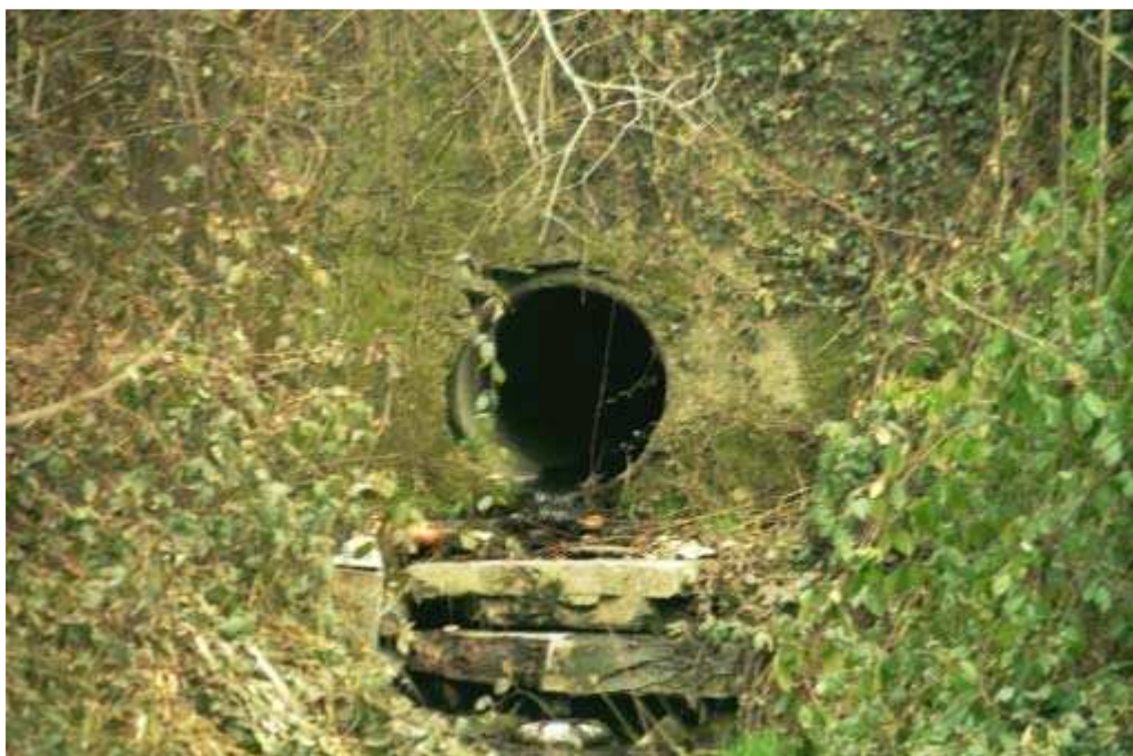
Foto 006 – Opera TREVAG006 . Ripresa da valle verso monte.
