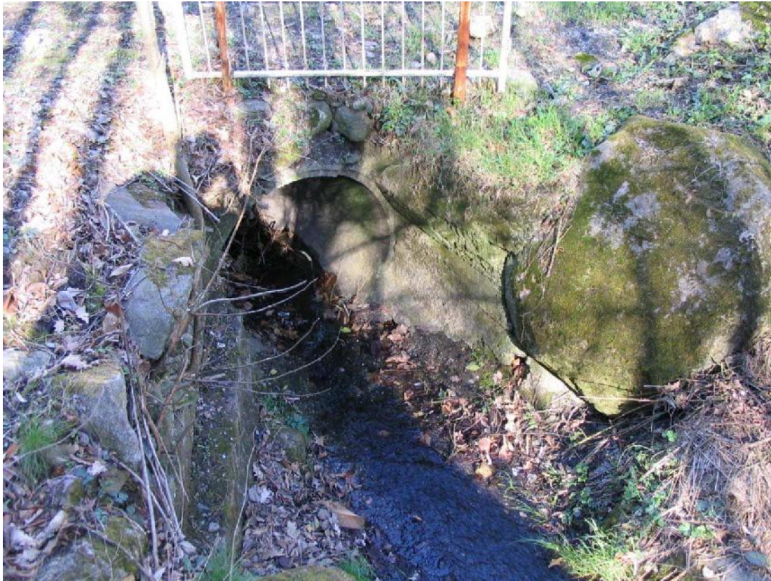
Foto 009 – Opera BATTCA009 . Ripresa da monte, sponda sinistra dell'impluvio.
