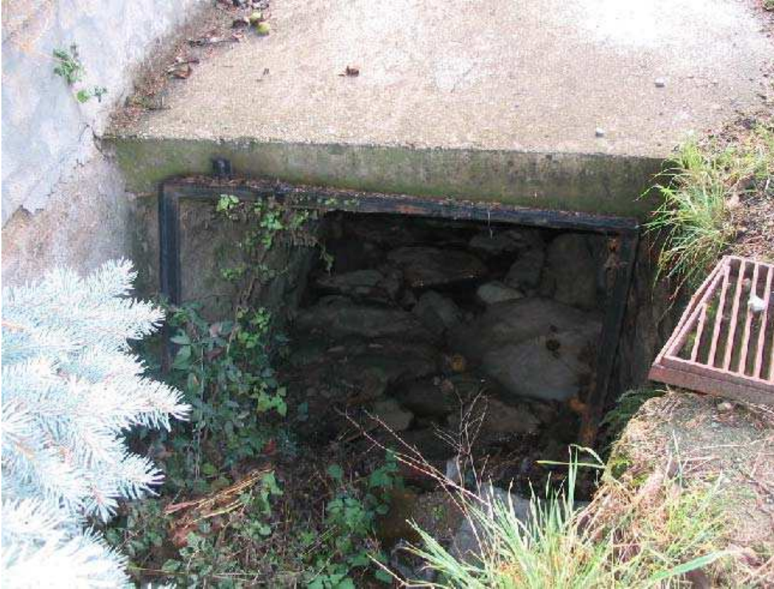
Foto 012 – Opera PENNCA013 . Ripresa dell'imbocco di monte, sponda destra del rio.
