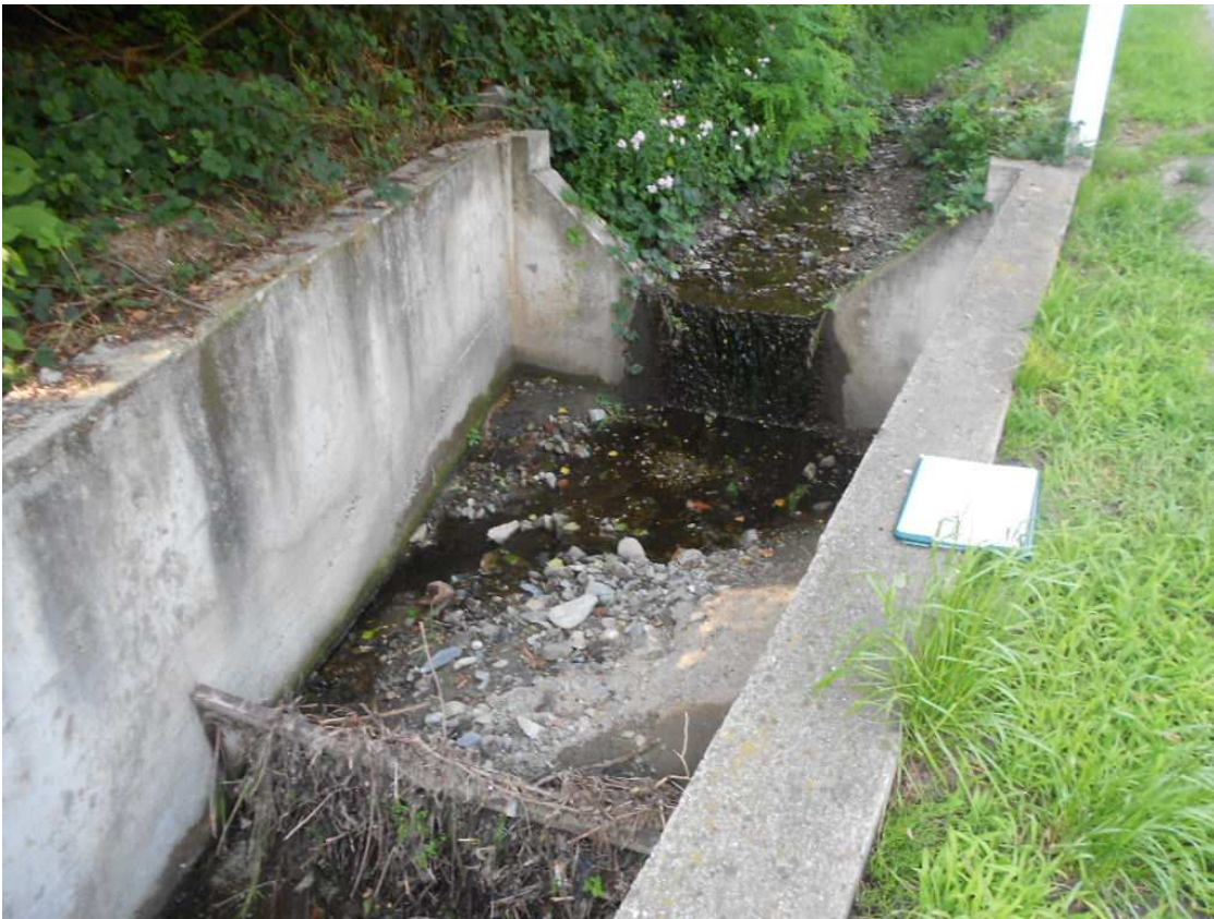
Foto 015 – Opera CASTBR015 . Ripresa da valle, sponda sinistra dell'impluvio.
