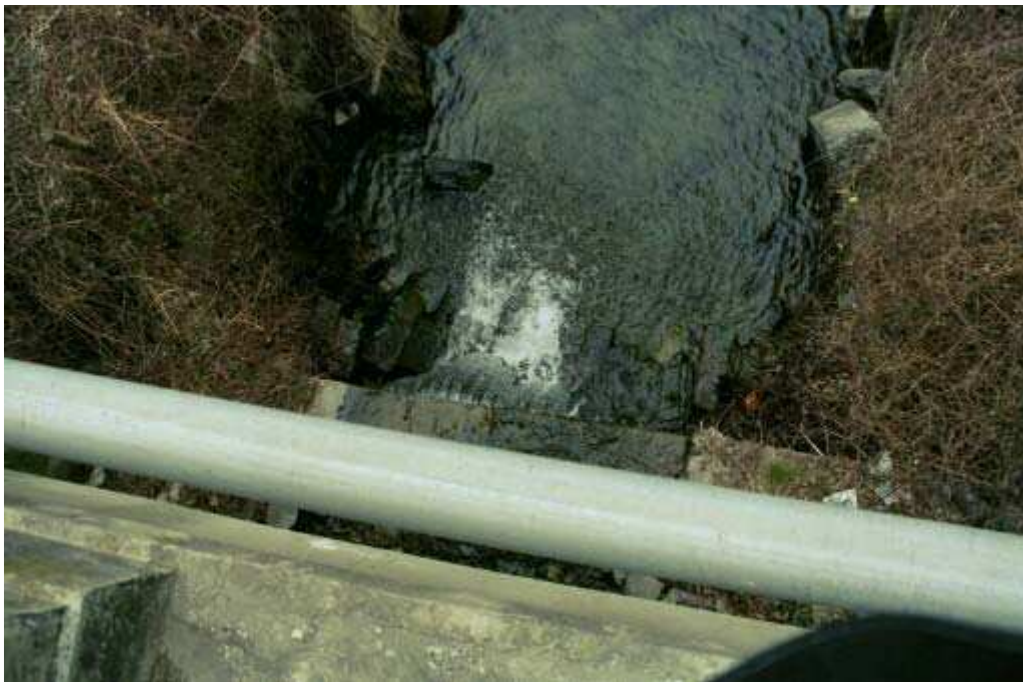
Foto 004 – Opera TREVSO004 . Ripresa da monte verso valle.
