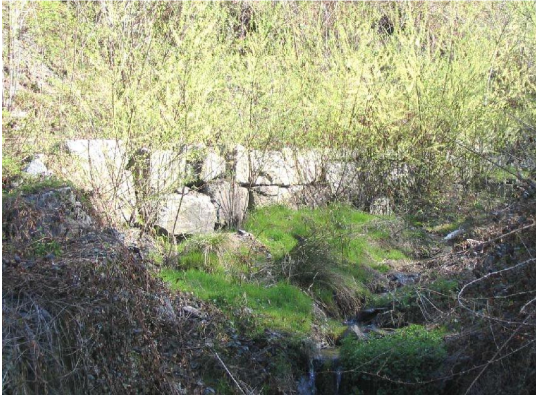
Foto 025 – Opera BATTD5025 . Ripresa da valle, dall'attraversamento CANAAG037.
