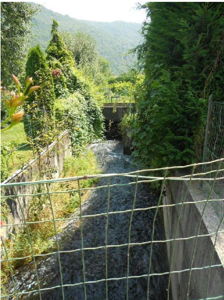
Foto 014 – Opera CASTCA018 . Ripresa dell'imbocco di monte, dall'attraversamento CASTAG061.
