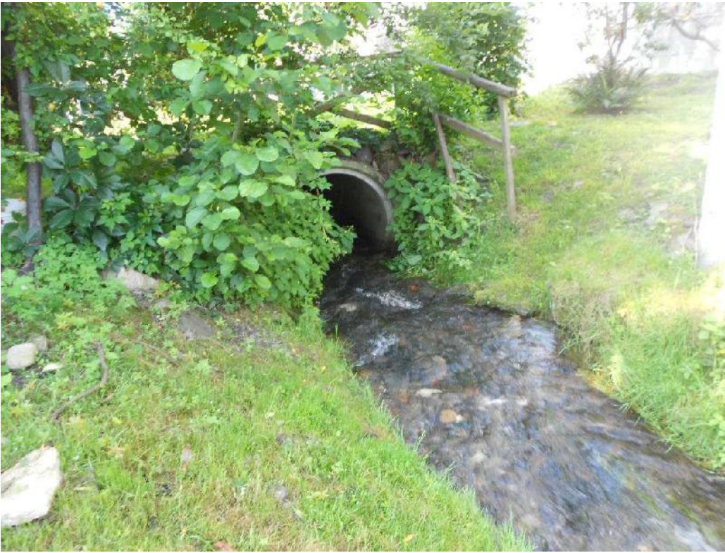
Foto 015 – Opera CASTCA020 . Ripresa dell'imbrocco di monte.
