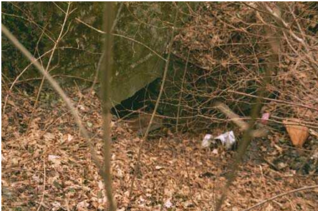
Foto 002 – Opera TREVAG002 . Ripresa da valle verso monte.
