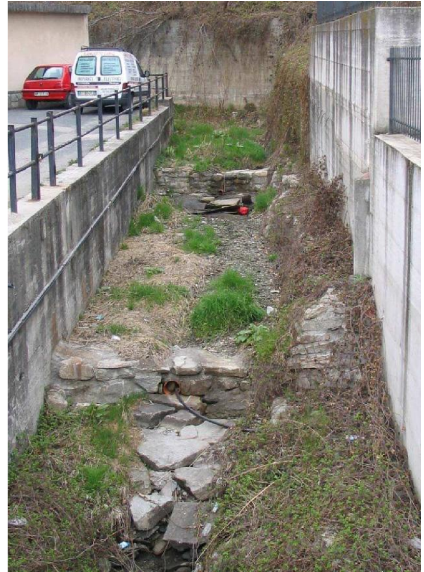
Foto 012 – Opere BATTBR012 (primo piano) e PENNBR013 (sullo sfondo). Ripresa da valle, dall'attraversamento TREVAG028 .
