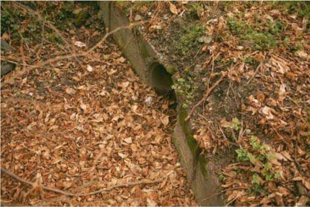
Foto 031 – Opera CANAAG031 . Ripresa da monte.
