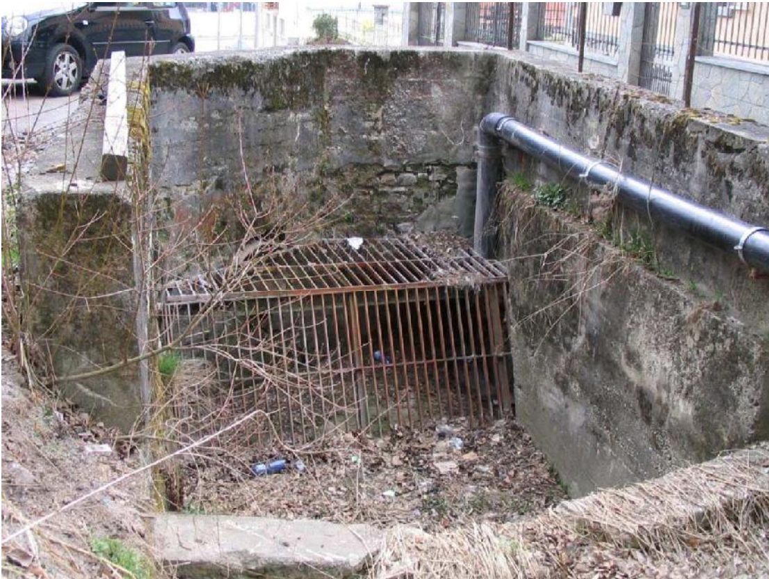
Foto 005 – Opera PENNCA005 . Ripresa da monte, sponda sinistra dell'impluvio.
