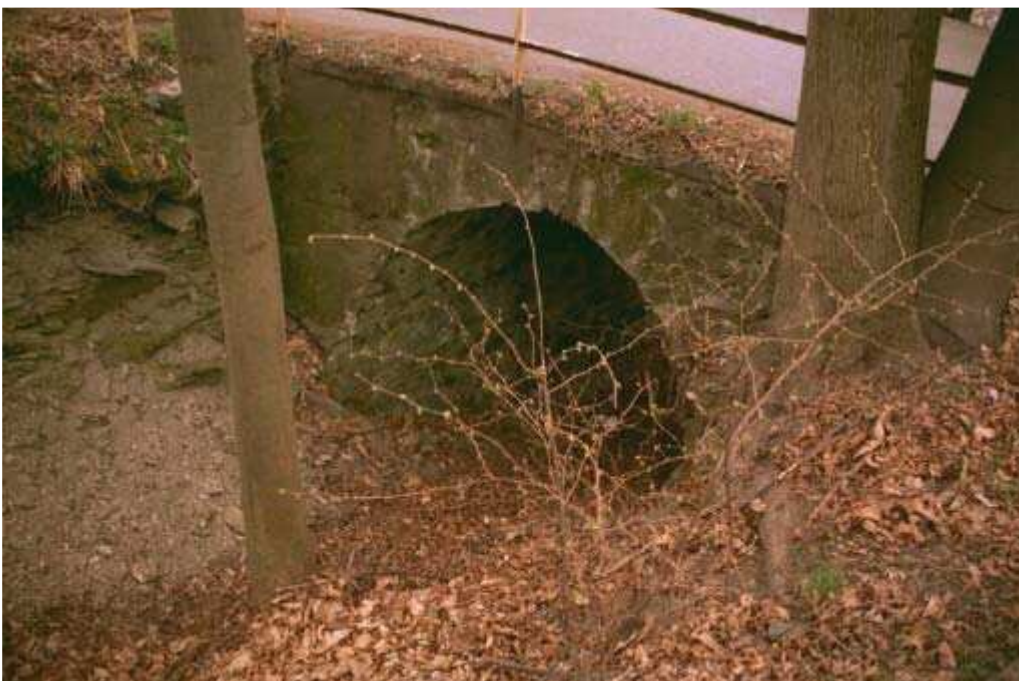
Foto 042 – Opera TREVAG044 . Ripresa da monte.
