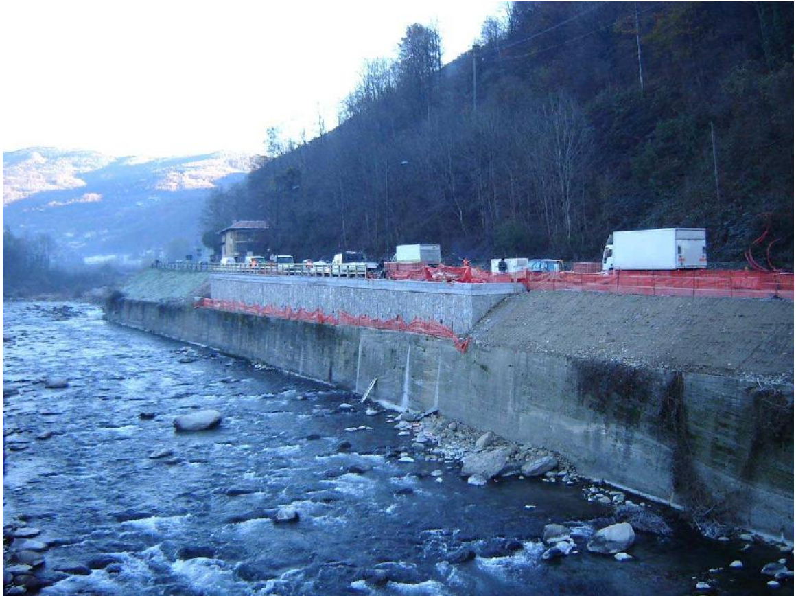
Foto 001 – Opera CANADS001 . Ripresa dal ponte CANAPO001 .
