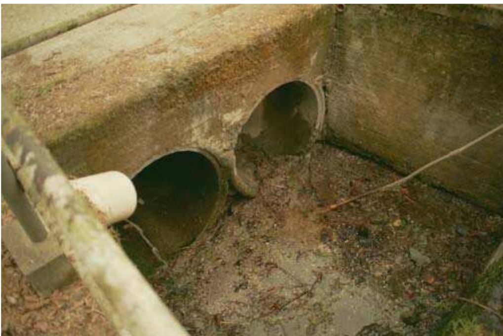
Foto 022 – Opera TREVAG022 . Ripresa da monte, sponda sinistra dell'impluvio.
