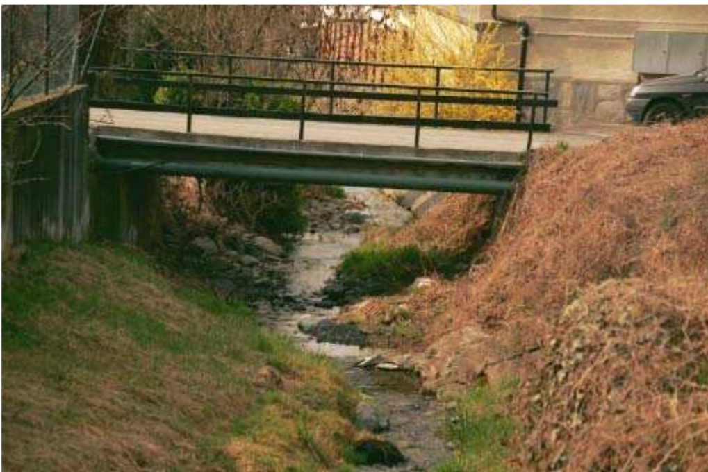
Foto 012 – Opera TREVAG012 . Ripresa da monte, sponda destra dell'impluvio.
