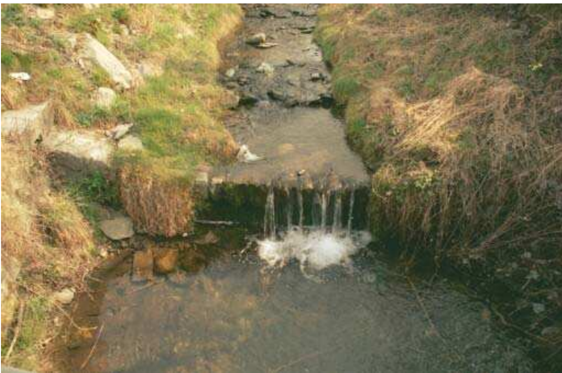
Foto 002 – Opera TREVBR002 . Ripresa da valle verso monte.
