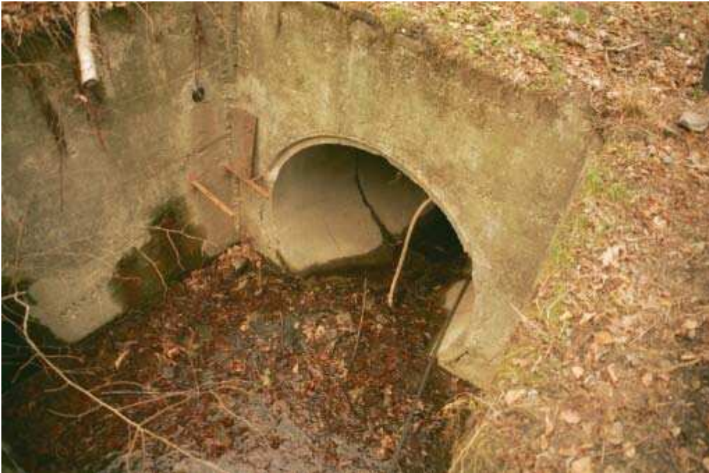
Foto 023 – Opera CANAAG023 . Ripresa da monte, sponda destra dell'impluvio.
