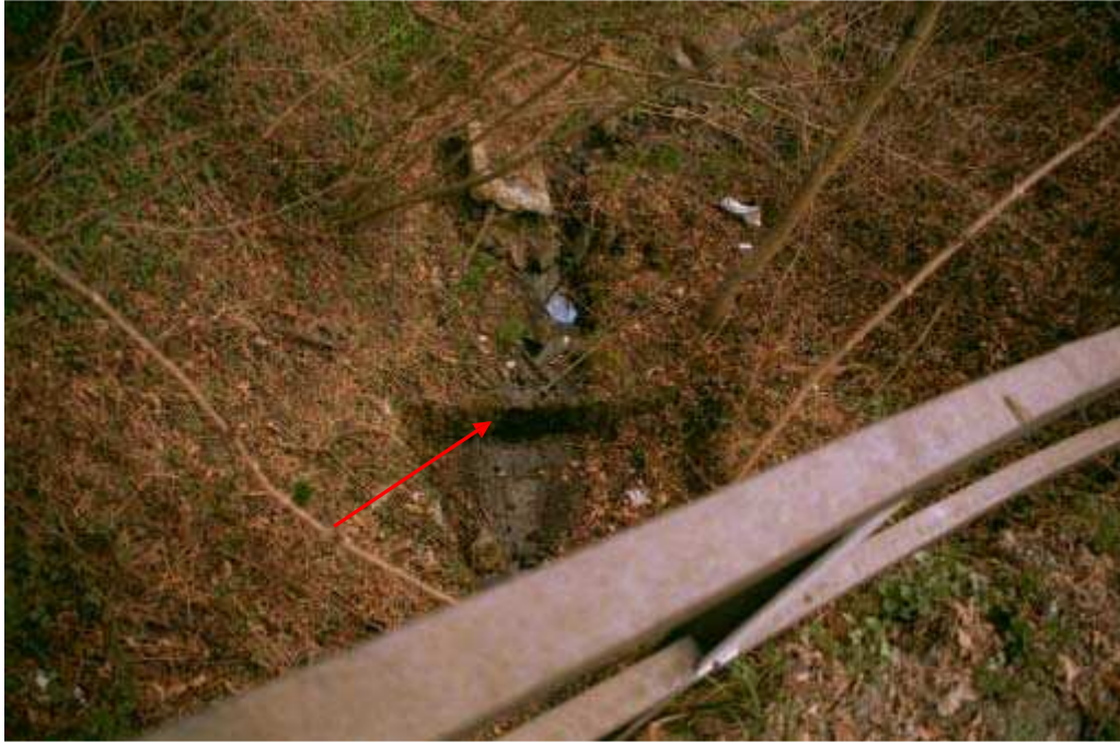
Foto 033 – Opera CANASO033 . Ripresa da valle verso monte.
