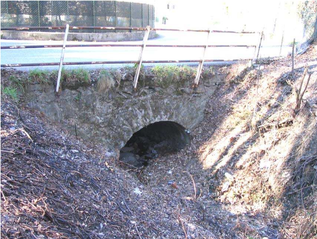
Foto 009 – Opera PENNCA009 . Ripresa da monte, sponda sinistra dell'impluvio.
