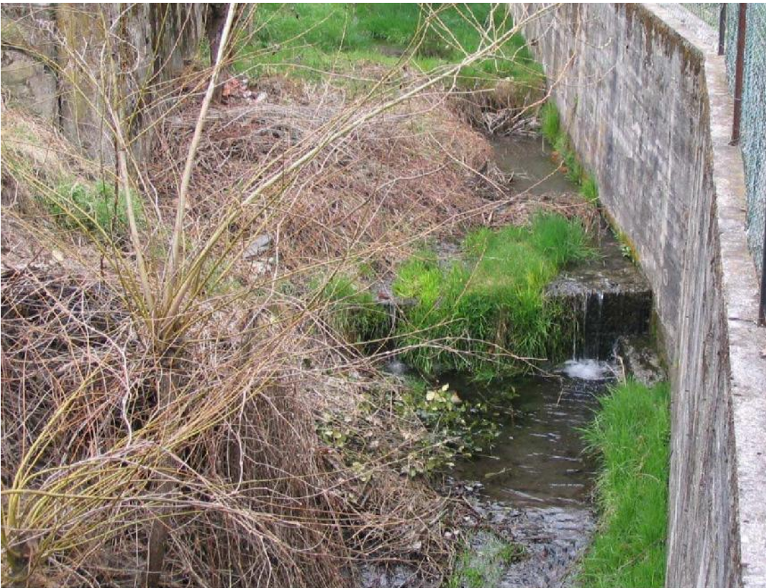
Foto 043 – Opera PENNSO043 . Ripresa da valle, dall'attraversamento PENNAG058.
