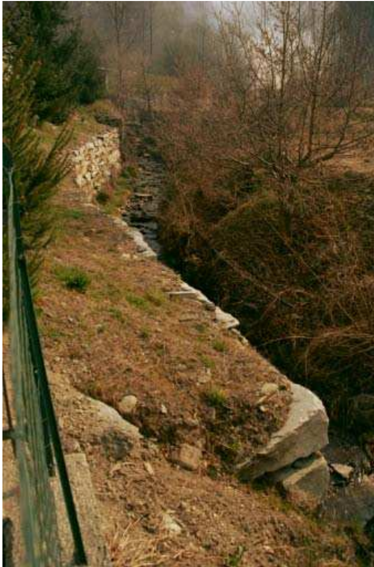
Foto 004 – Opera TREVDS004 . Ripresa da monte verso valle.
