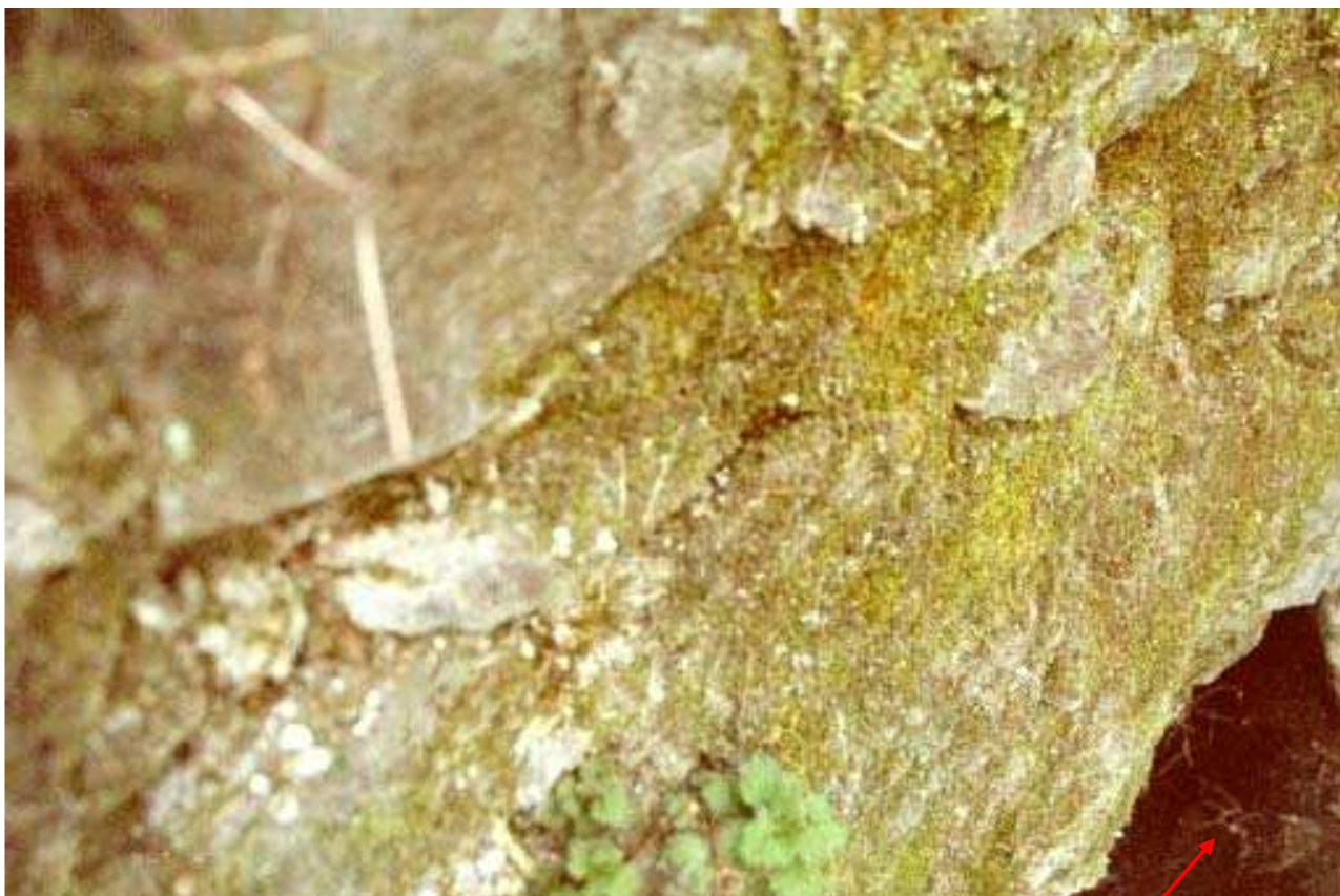
Foto 006 – Opera TREVAG006 . Ripresa da valle verso monte.
