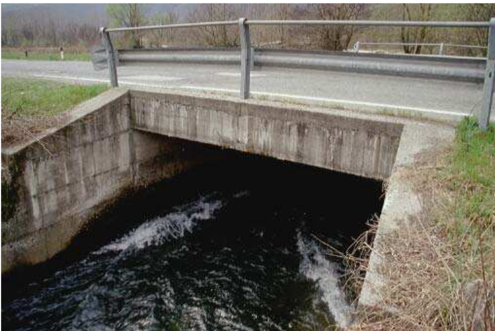
Foto 050 – Opera CANAAG052 . Ripresa da monte.
