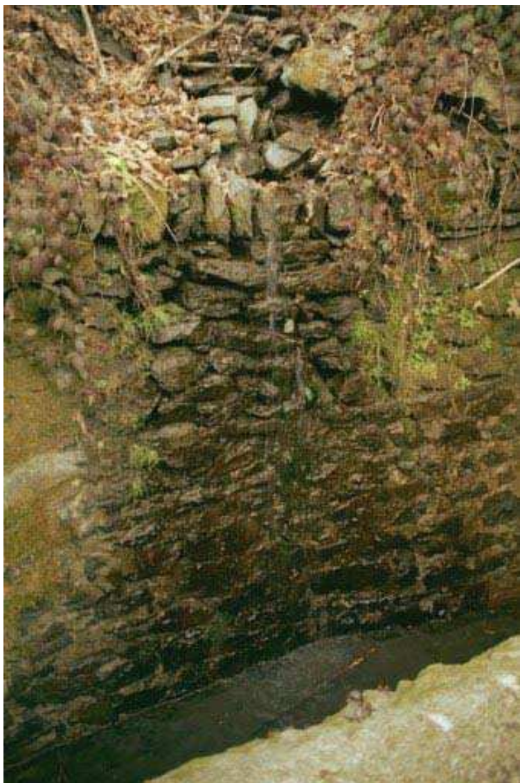
Foto 003 – Opera TREVS003 . Ripresa da valle verso monte.
