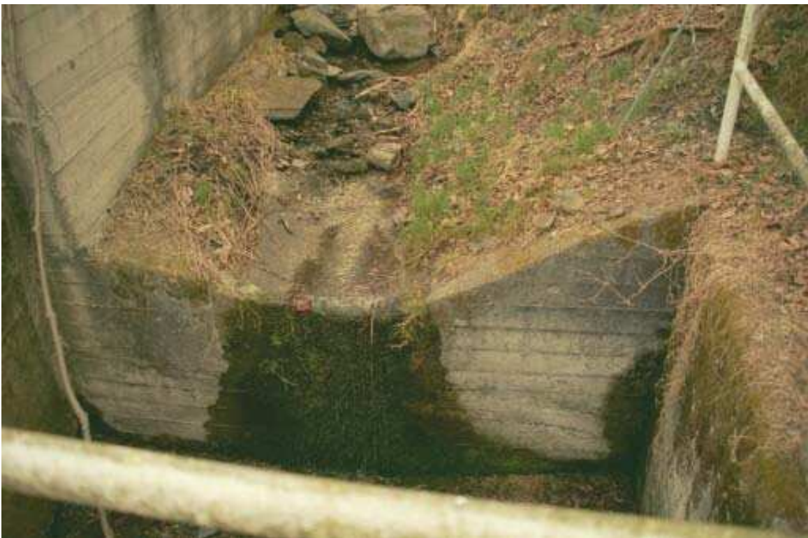
Foto 004 – Opera TREVBR004 . Ripresa da valle verso monte.
