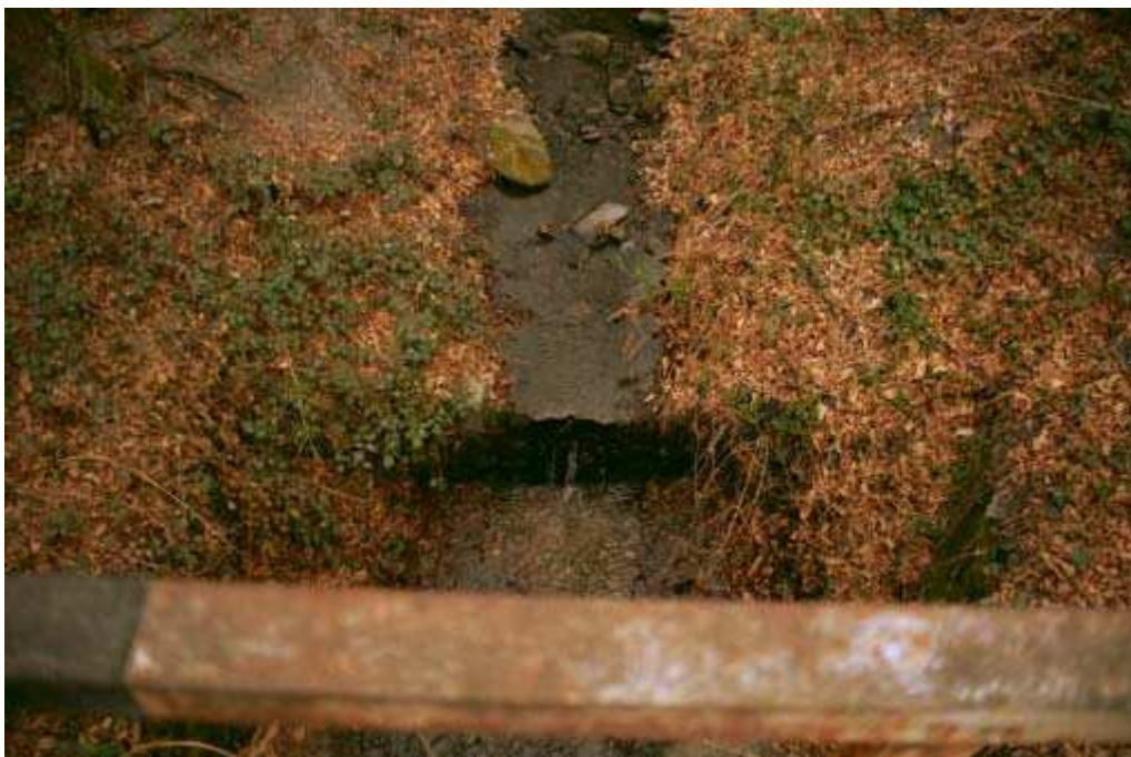
Foto 031 – Opera CANASO031 . Ripresa da valle verso monte.
