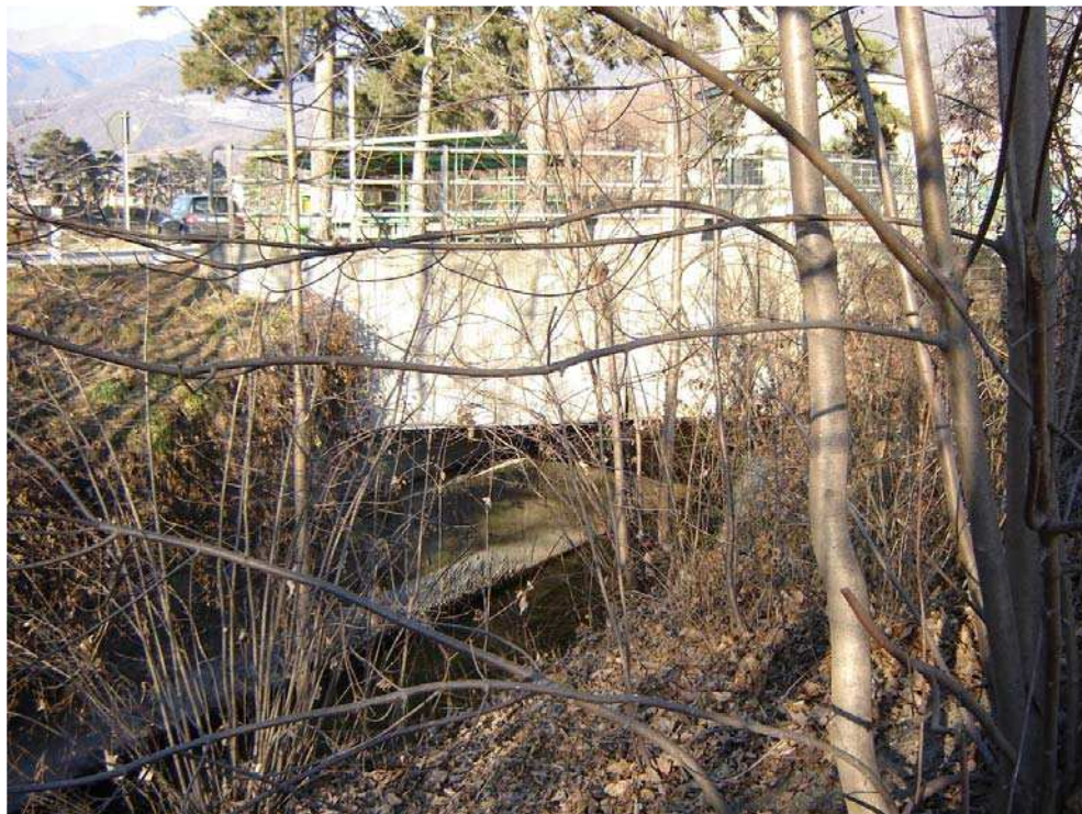
Foto 051 – Opera TREVAG053 . Ripresa da valle, sponda sinistra del T. Chisone.
