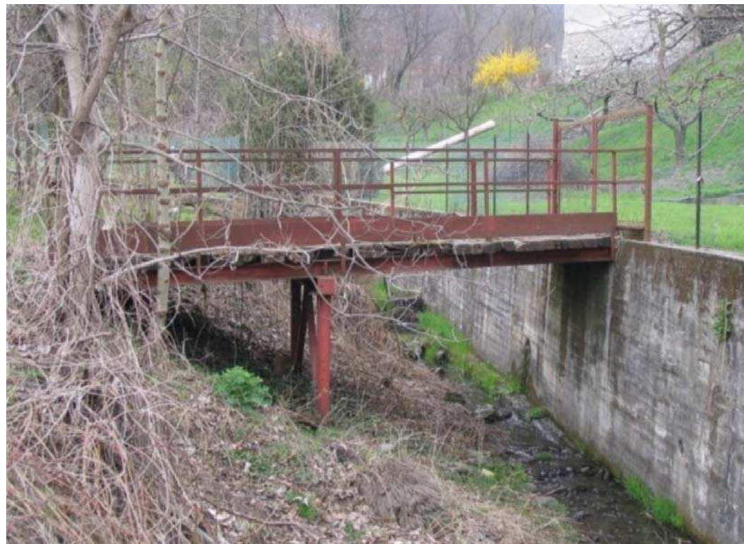
Foto 056 – Opera PENNAG058 . Ripresa da valle, sponda destra dell'impluvio.
