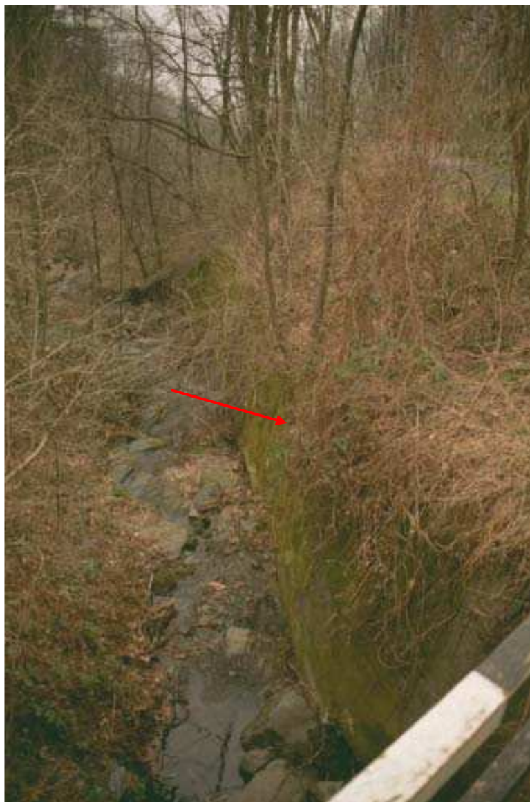
Foto 009 – Opera CANADS009 . Ripresa da valle verso monte.
