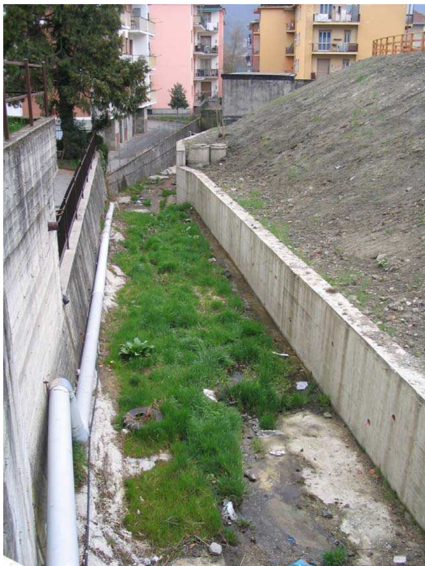
Foto 007 – Opera PENNCA007 . Ripresa da monte.
