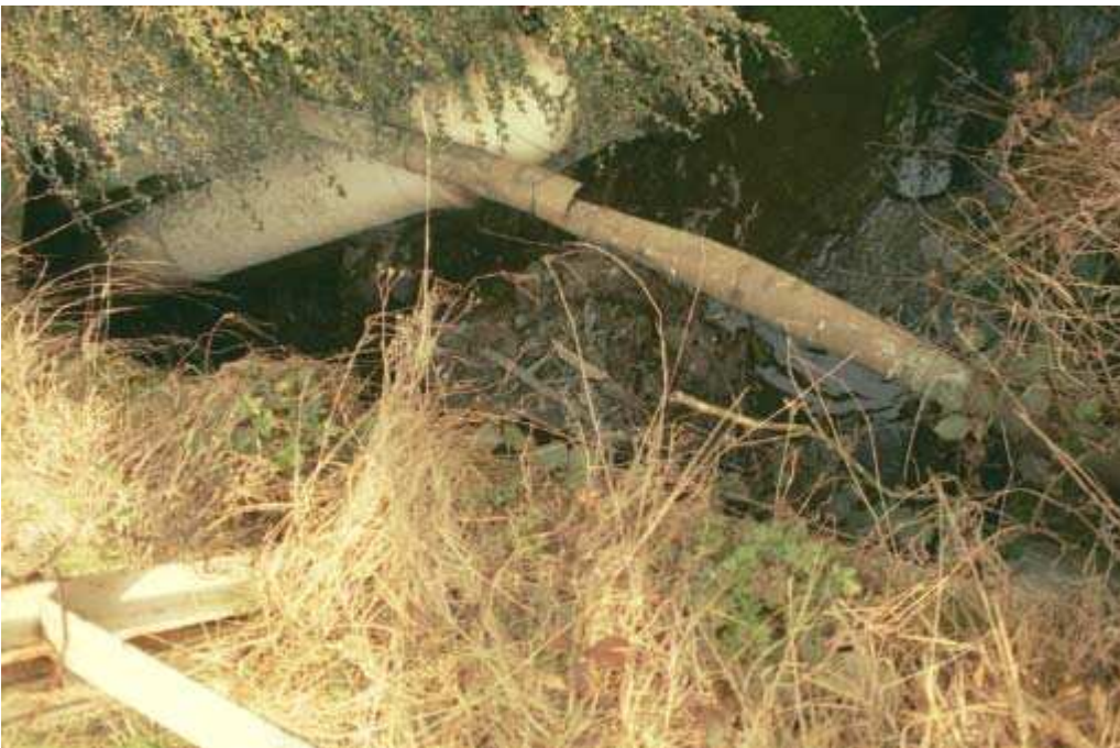
Foto 008 – Opera TREVAG008 . Ripresa da monte, sponda sinistra.
