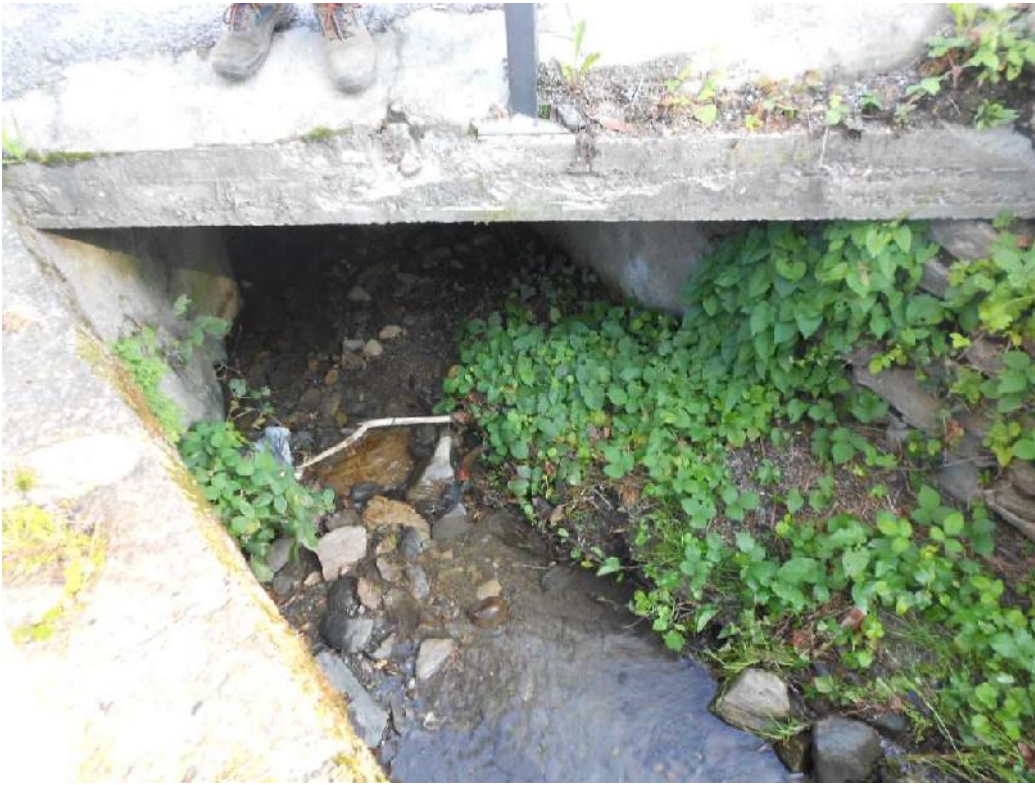
Foto 017 – Opera CASTCA022 . Ripresa dell'imbocco di monte.
