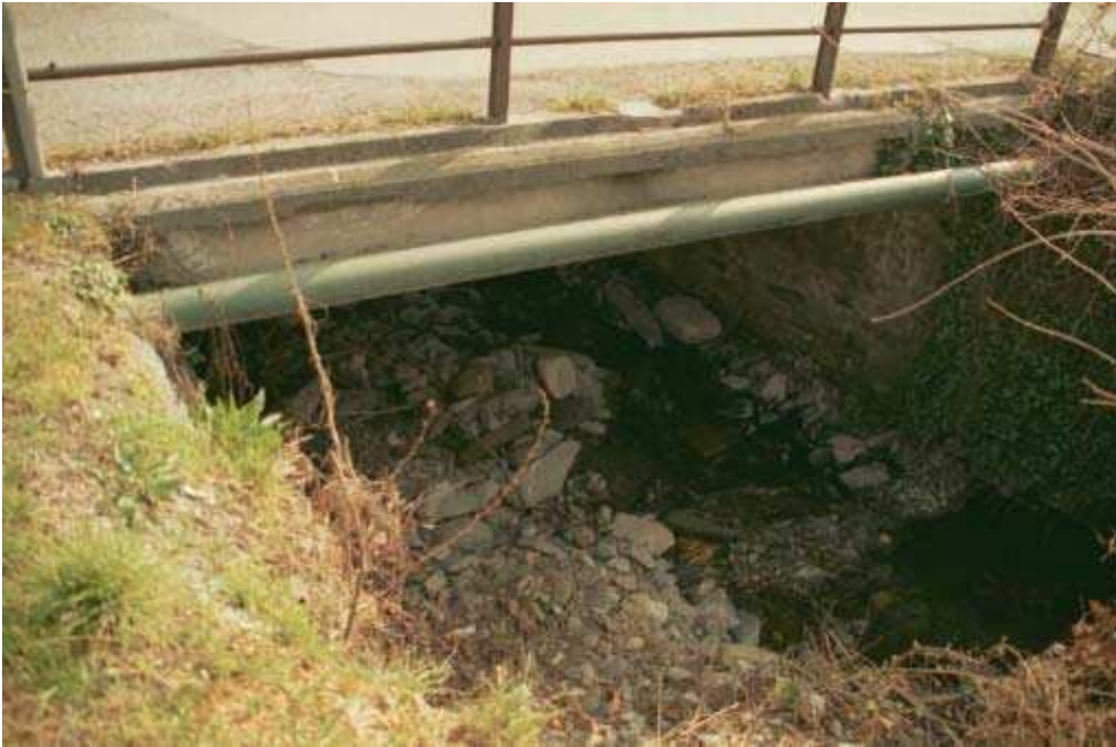
Foto 0011 – Opera CANAAG011 . Ripresa da valle, sponda destra dell'impluvio.
