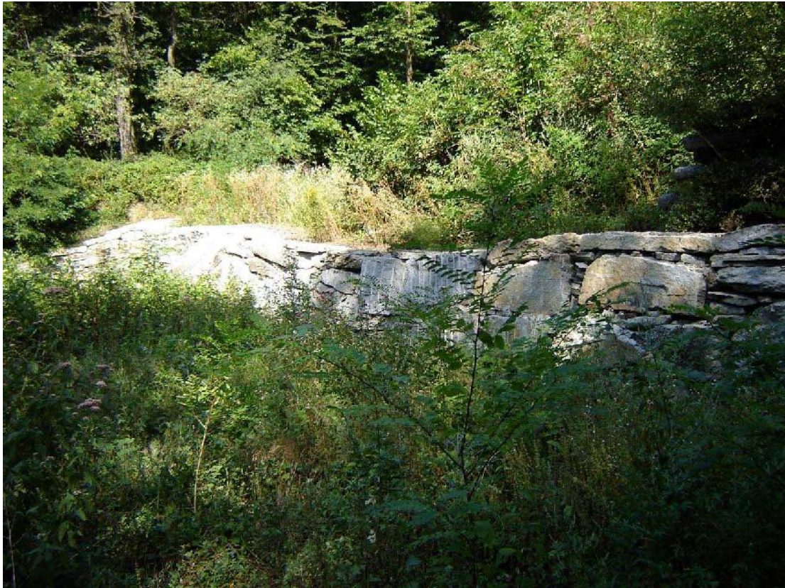
Foto 027 – Opera BATTDS027 . Ripresa da sponda sinistra del rio.
