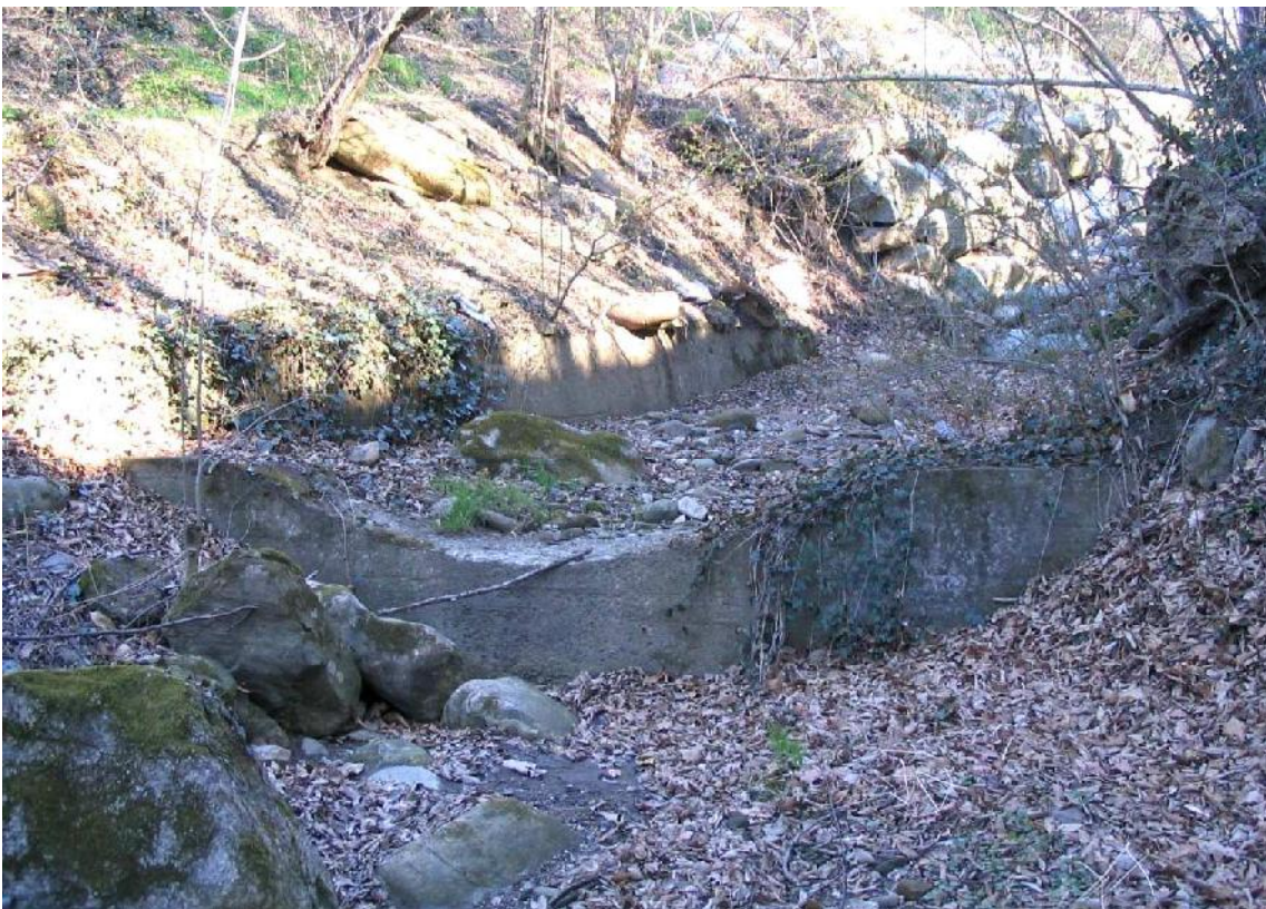
Foto 014 – Opera PENNBR015 . Ripresa da valle, dal greto dell'impluvio.
