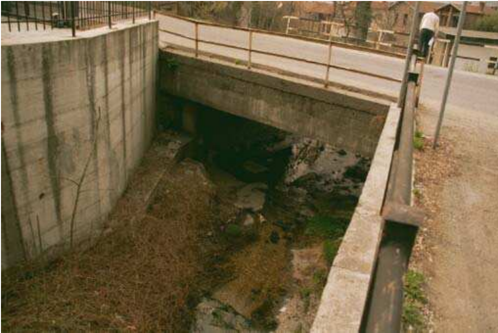
Foto 022 – Opera CANAAG027 . Ripresa monte, sponda destra dell'impluvio.
