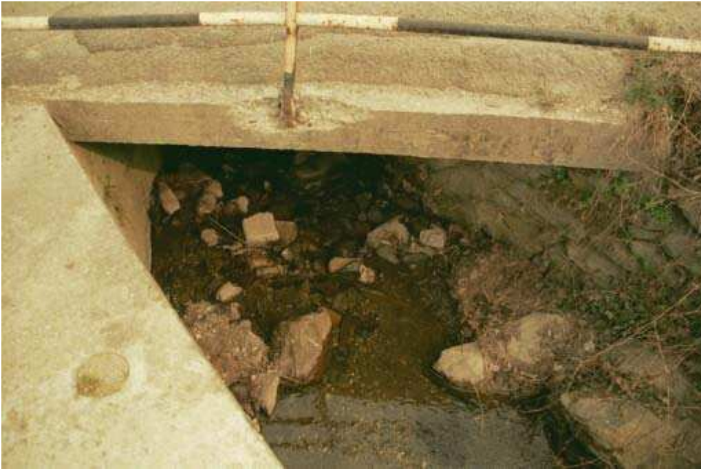
Foto 019 – Opera CANAAG019 . Ripresa da monte, sponda sinistra dell'impluvio.
