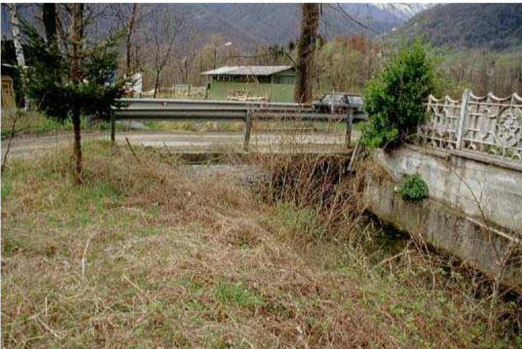
Foto 048 – Opera TREVAG050 . Ripresa da monte.
