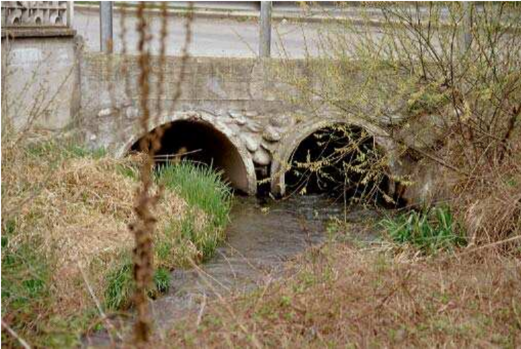
Foto 049 – Opera TREVAG051 . Ripresa da valle.
