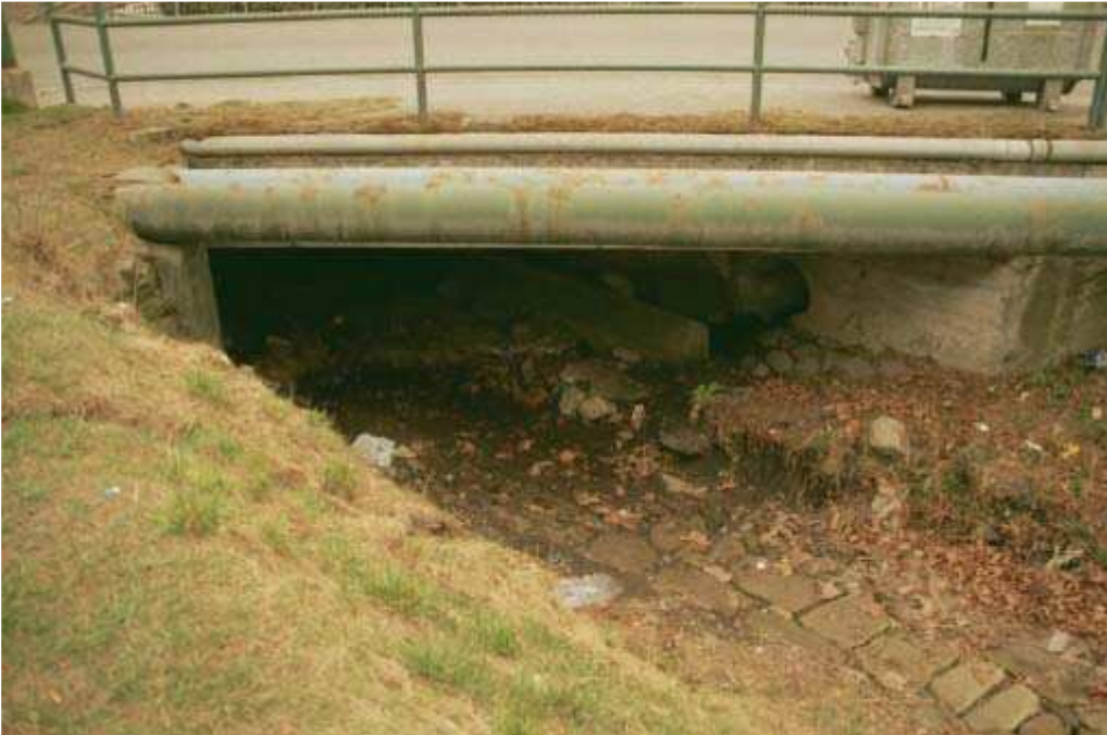
Foto 046 – Opera TREVAG048 . Ripresa da monte.
