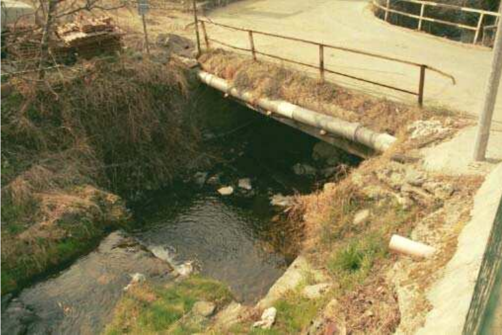
Foto 009 – Opera CANAAG009 . Ripresa da monte, sponda destra dell'impluvio.
