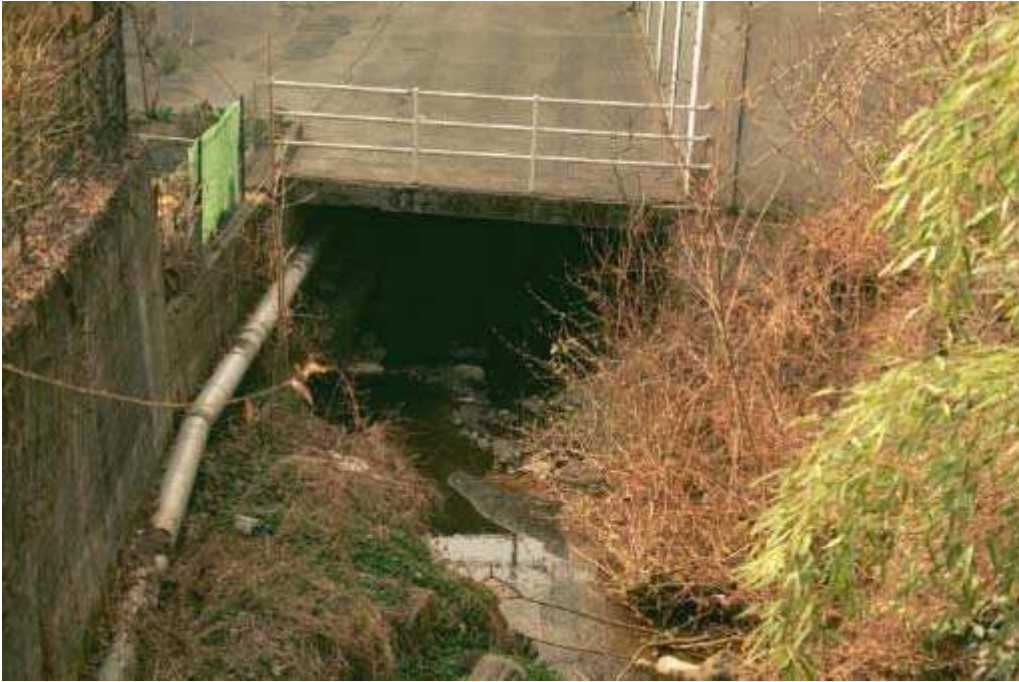
Foto 015 – Opera CANAAG015 . Ripresa da monte, sponda destra dell'impluvio.
