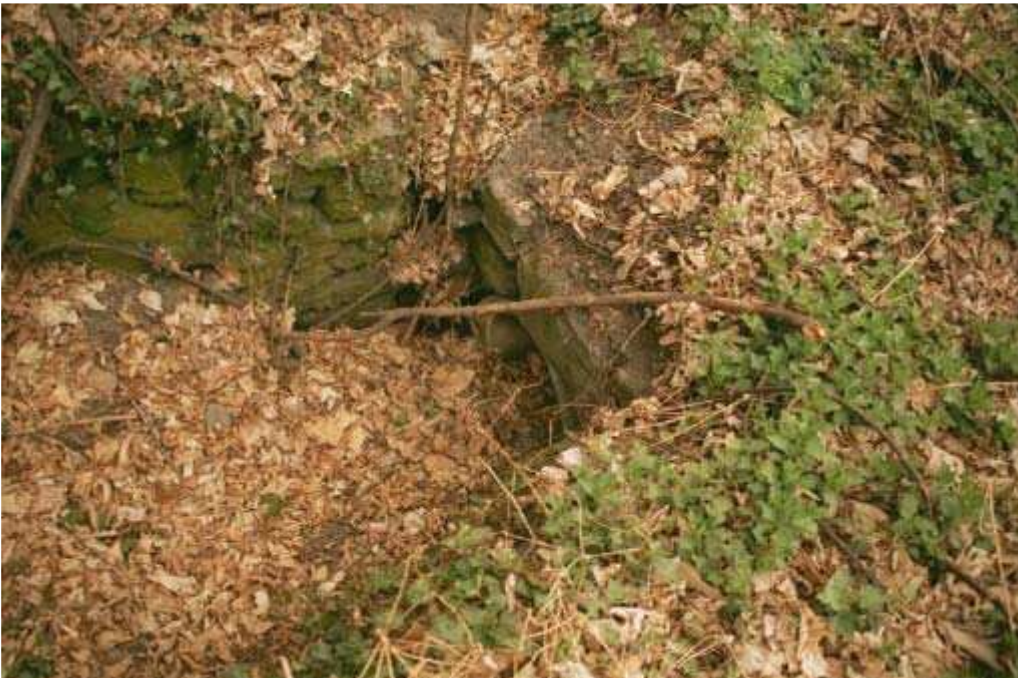
Foto 032 – Opera TREVAG032 . Ripresa da monte.
