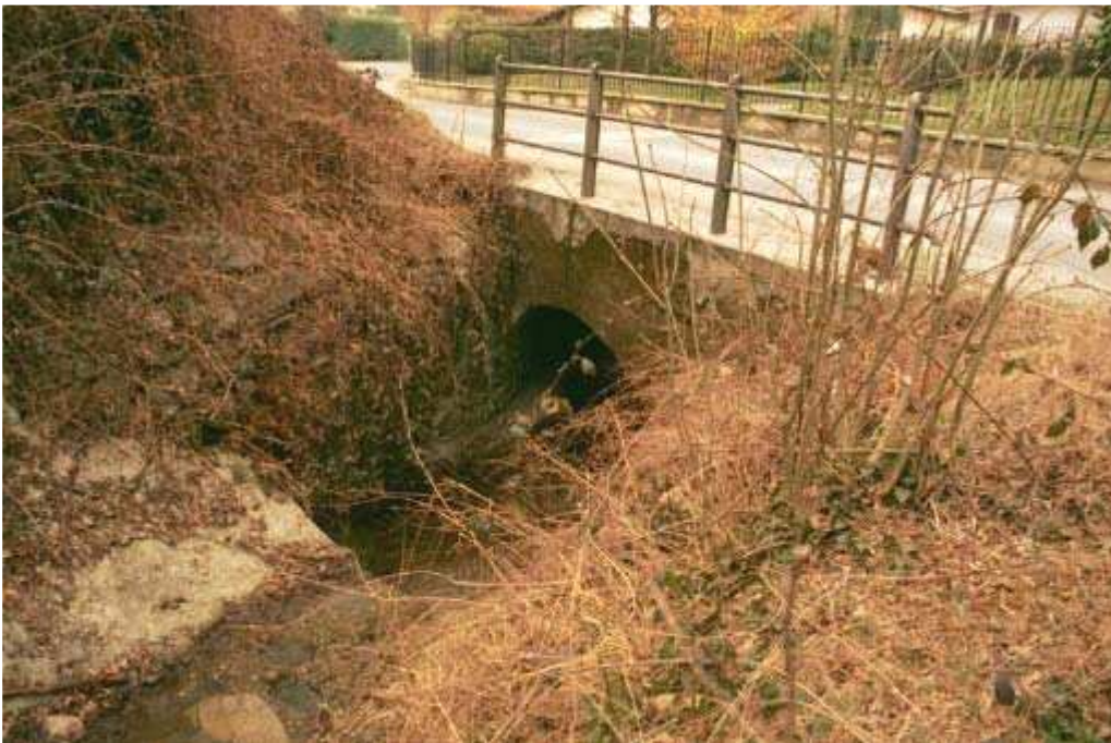
Foto 016 – Opera TREVAG016 . Ripresa da monte, sponda destra dell'impluvio.
