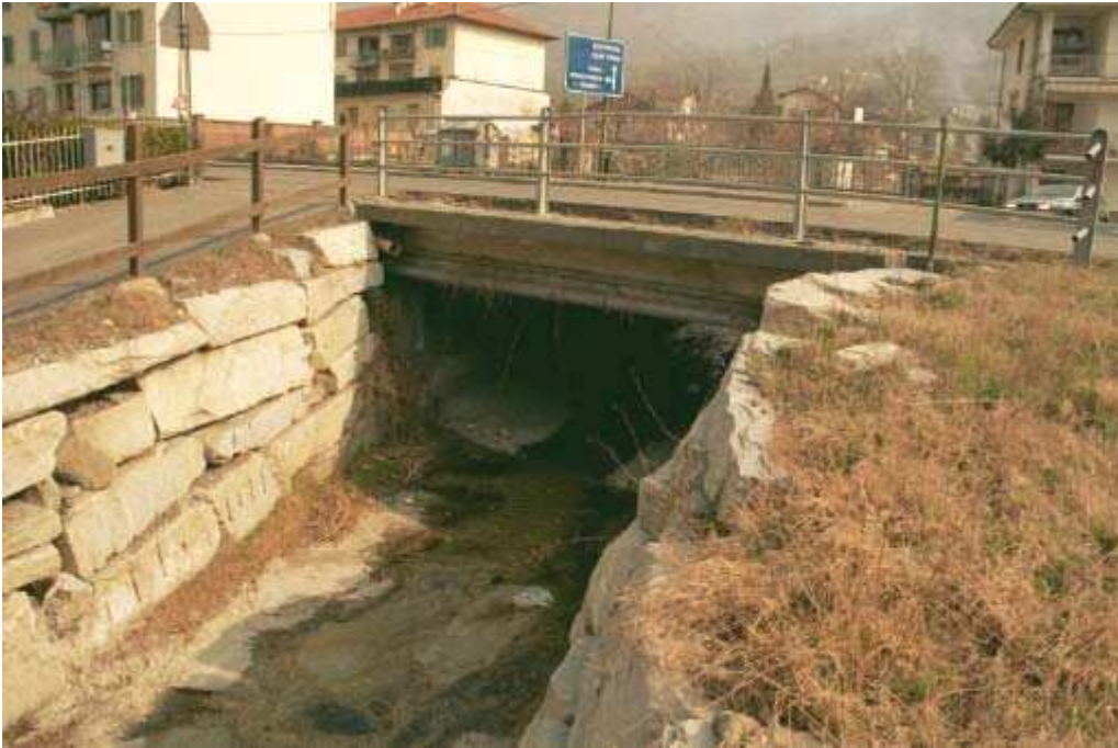
Foto 013 – Opera CANAAG013 . Ripresa da valle, sponda sinistra dell'impluvio.
