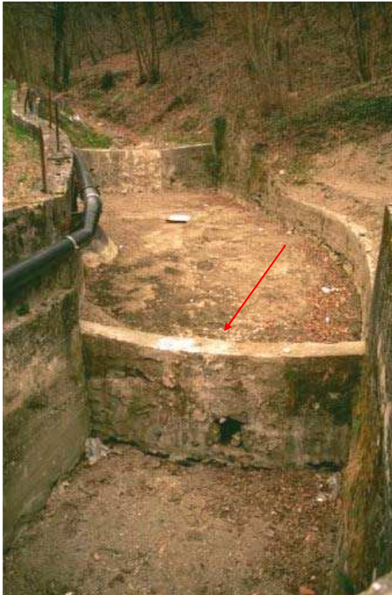
Foto 039 – Opere CANASO039 e CANASO049 . Ripresa da valle verso monte.
