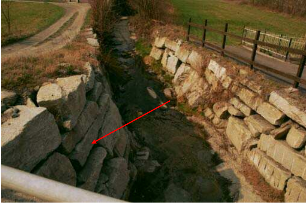
Foto 006 – Opera TREVDS006 . Ripresa da monte verso valle.
