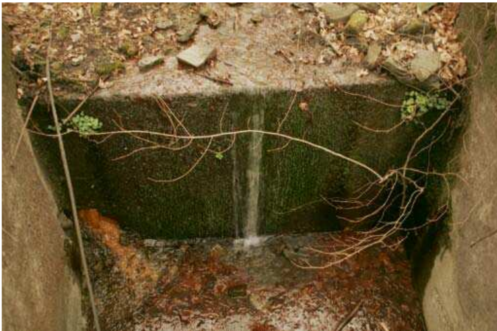
Foto 019 – Opera CANASO019 . Ripresa da valle verso monte.
