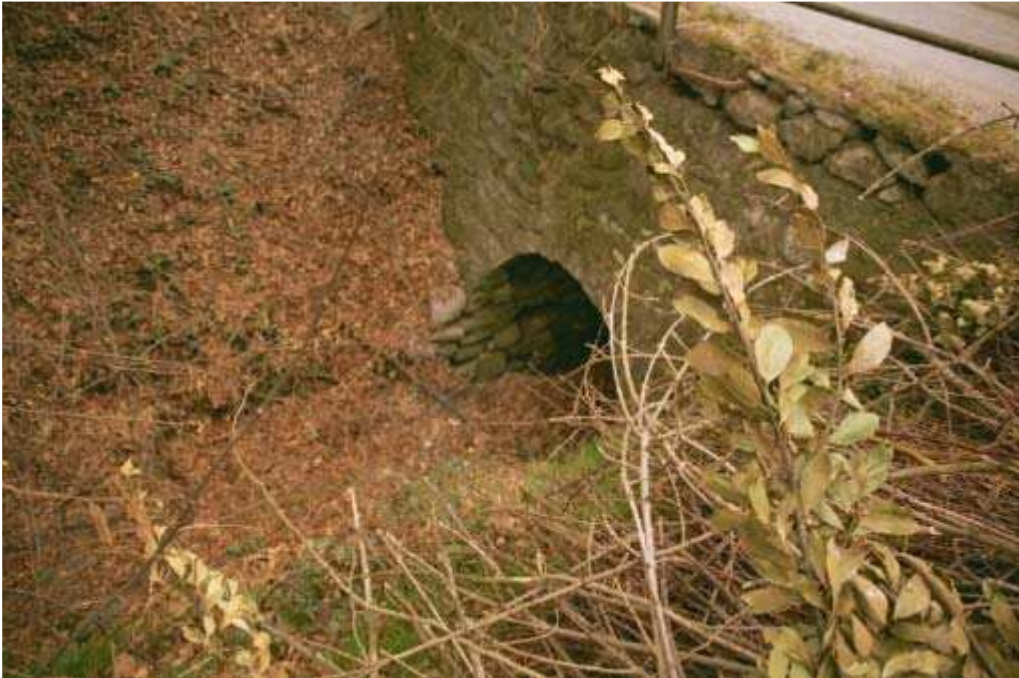
Foto 028 – Opera TREVAG028 . Ripresa da monte sponda destra dell'impluvio.
