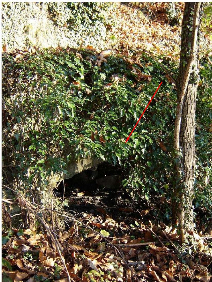
Foto 055 – Opera BATTAG057 . Ripresa da valle, sponda destra del Rio La Rui
