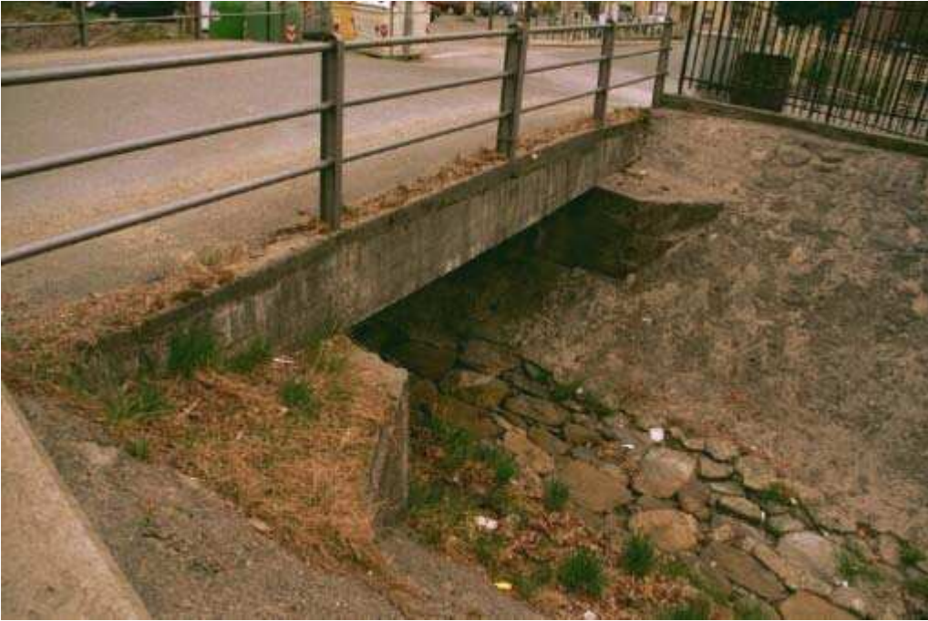
Foto 047 – Opera CANAAG049 . Ripresa da monte.
