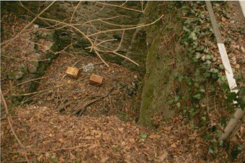
Foto 030 – Opera TREVAG030 . Ripresa da monte sponda destra dell'impluvio.
