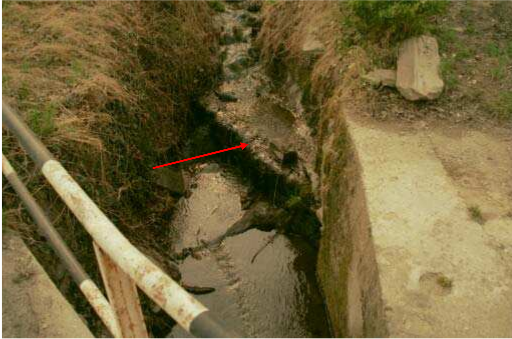
Foto 018 – Opera TREVSO018 . Ripresa da valle verso monte.
