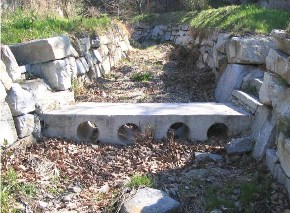
Foto 044 – Opera BATTSO044 . Ripresa frontale da valle, dal greto dell'impluvio.
