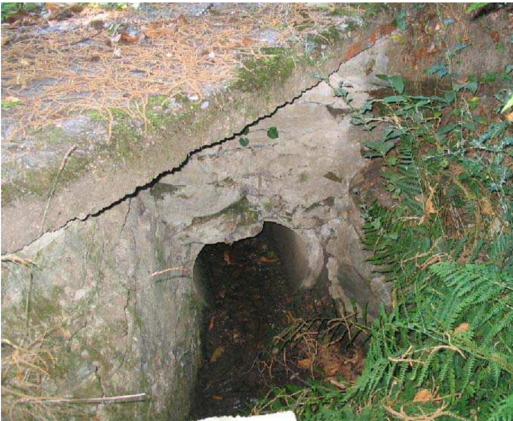
Foto 058 – Opera PENNAG060 . Ripresa da monte, sponda sinistra dell'impluvio.
