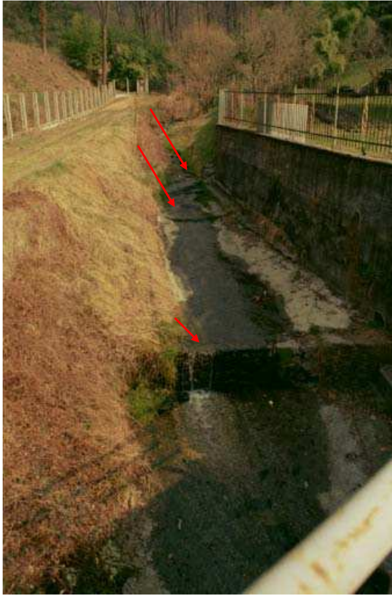
Foto 015 – Opera CANASO015 . Ripresa da valle verso monte.
