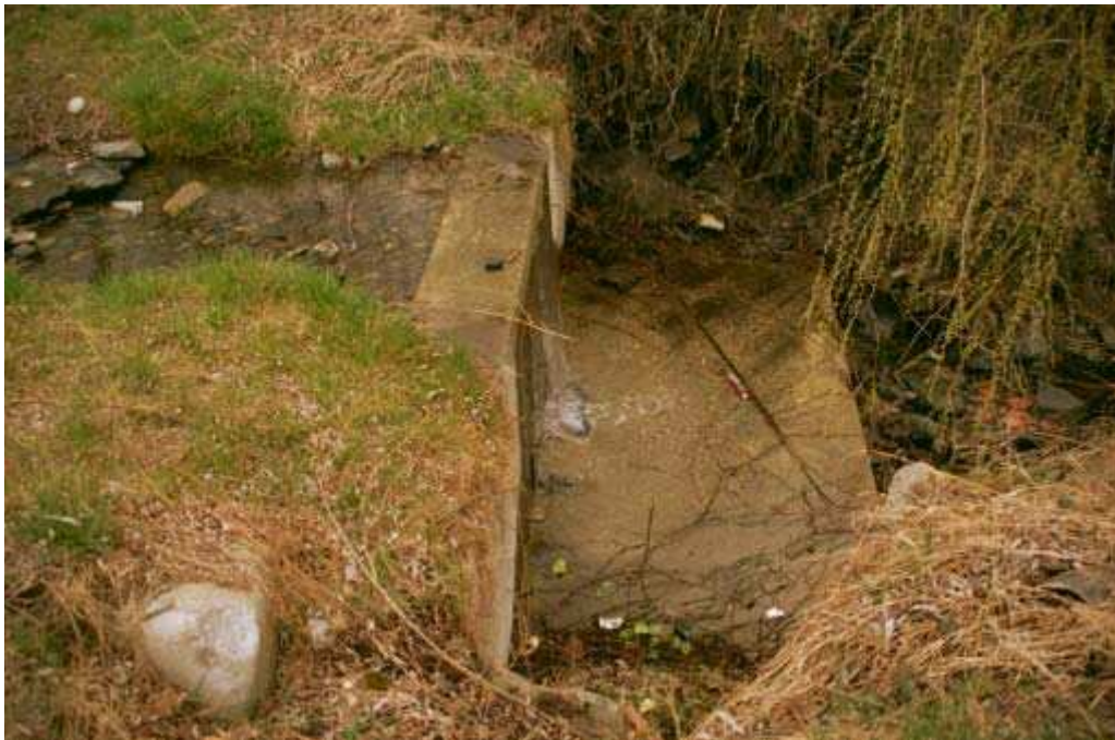
Foto 036 – Opera TREVSO036 . Ripresa laterale.
