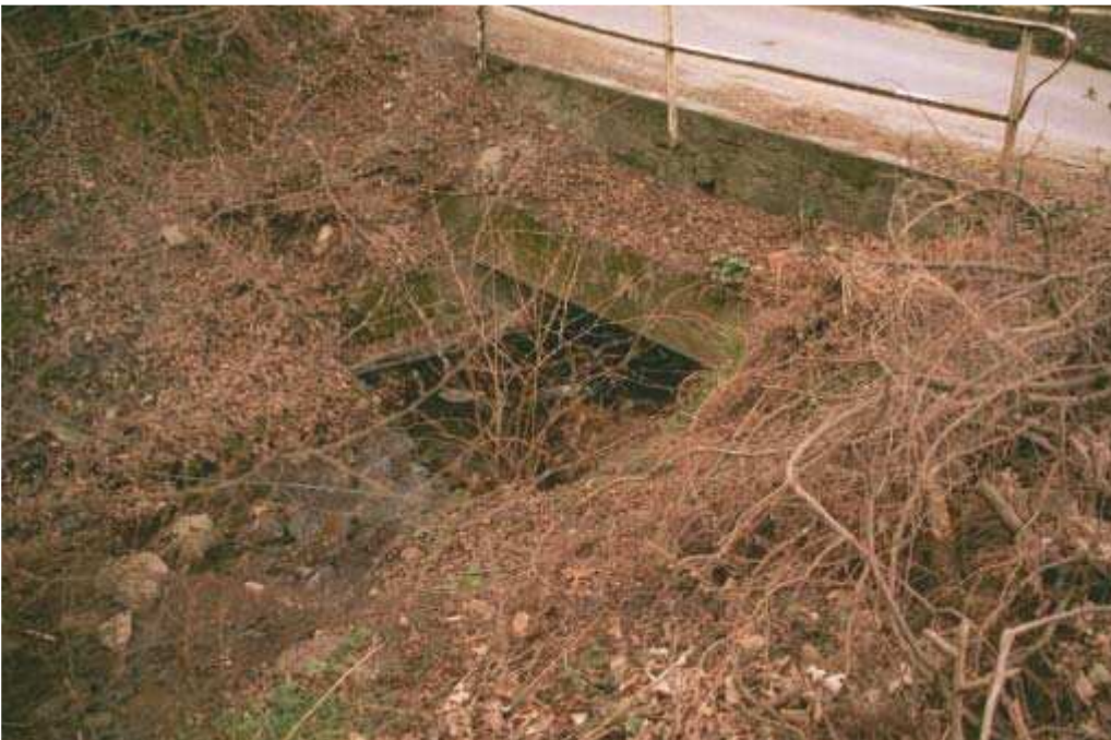
Foto 018 – Opera TREVAG018 . Ripresa da monte, sponda destra dell'impluvio.
