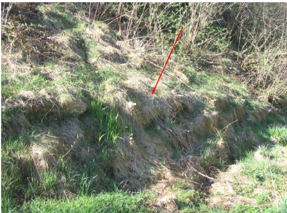
Foto 024 – Opera PENNDS024 . Ripresa da monte, sponda destra della Roggia Rifugi.
