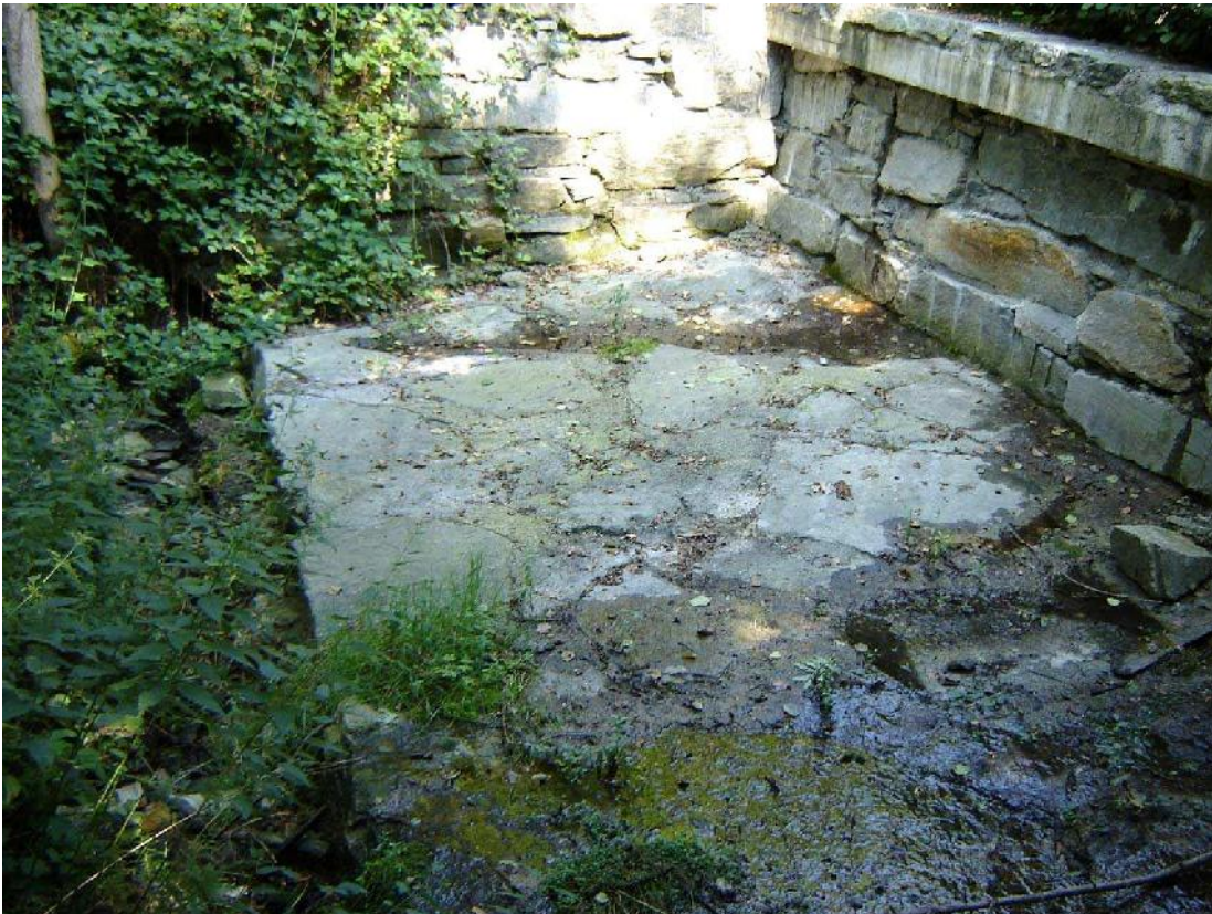
Foto 047 – Opera PENNSO047 . Ripresa frontale da valle, dal greto dell'impluvio.
