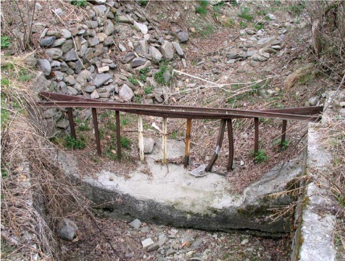
Foto 013 – Opera BATTBR014 . Ripresa da valle, dalla canalizzazione BATTCA008 .
