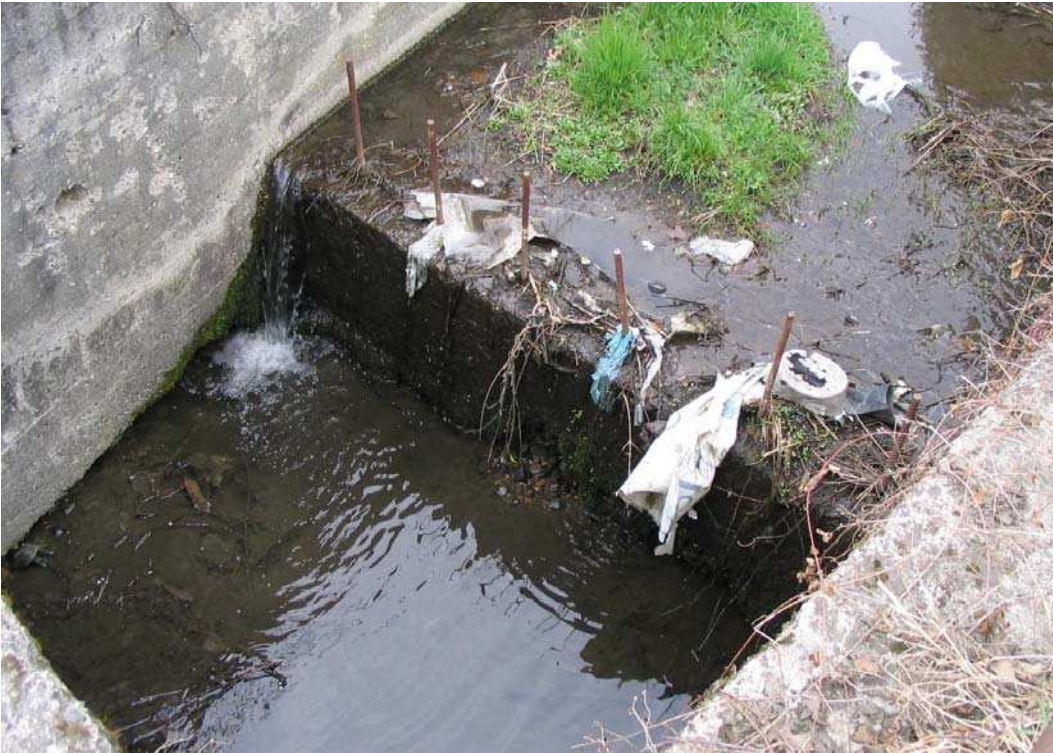
Foto 006 – Opera TREVS006 . Ripresa da valle, dalla canalizzazione CANACA001 .
