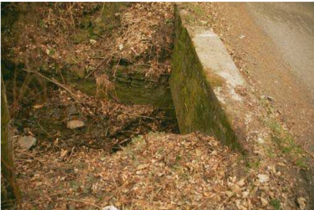
Foto 034 – Opera TREVAG036 . Ripresa da monte, sponda destra dell'impluvio.
