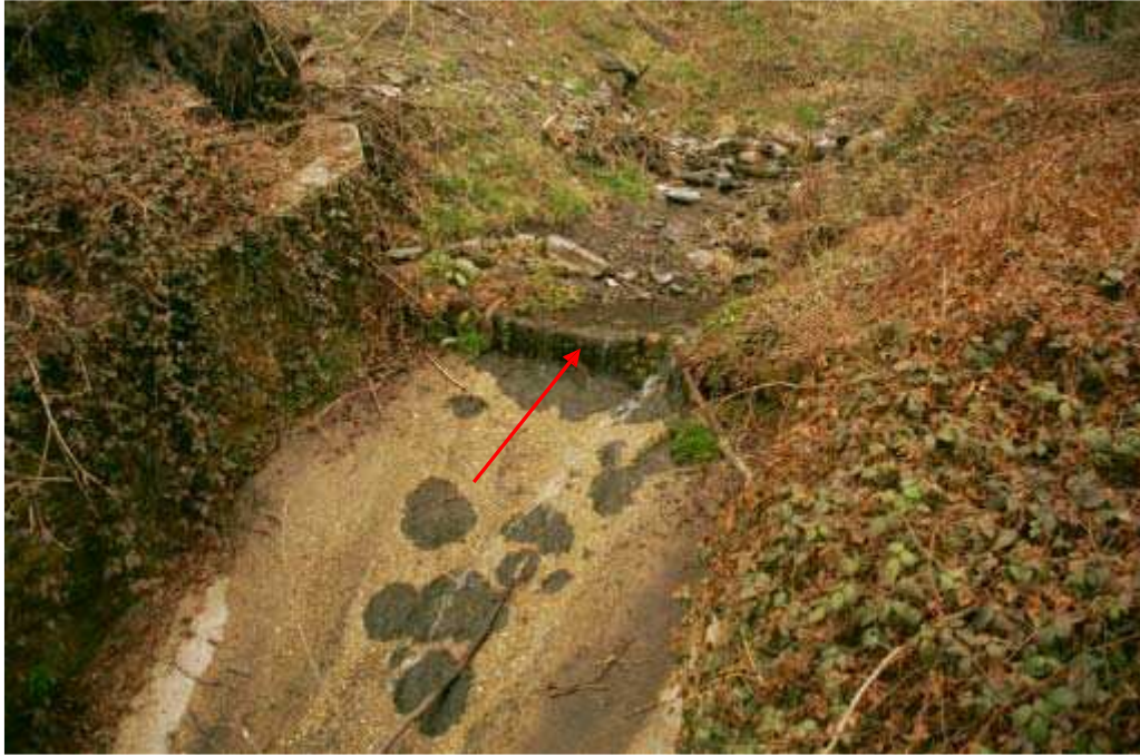
Foto 035 – Opera CANASO035 . Ripresa da valle verso monte.
