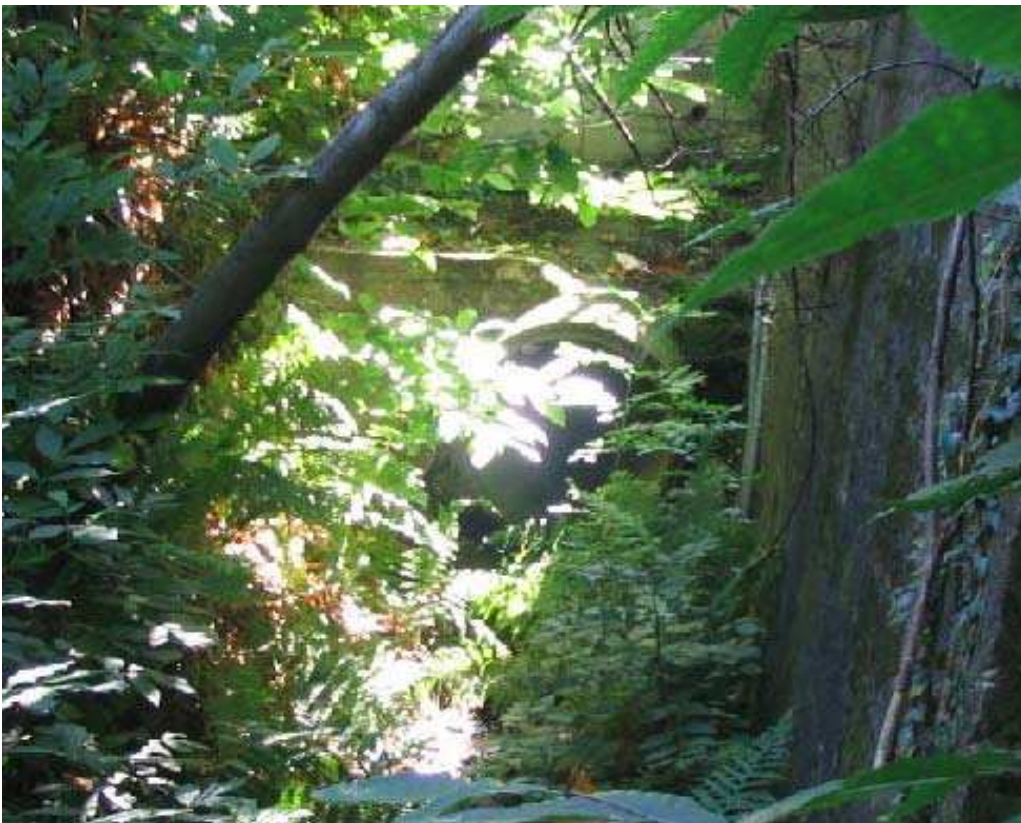
Foto 012 – Opera BATTCA012 . Ripresa dello sbocco a valle, dall'attraversamento PENNAG060.
