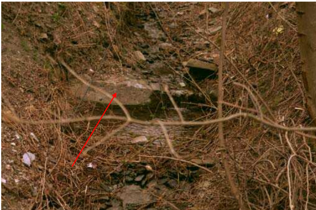
Foto 023 – Opera CANASO023 . Ripresa da valle verso monte.
