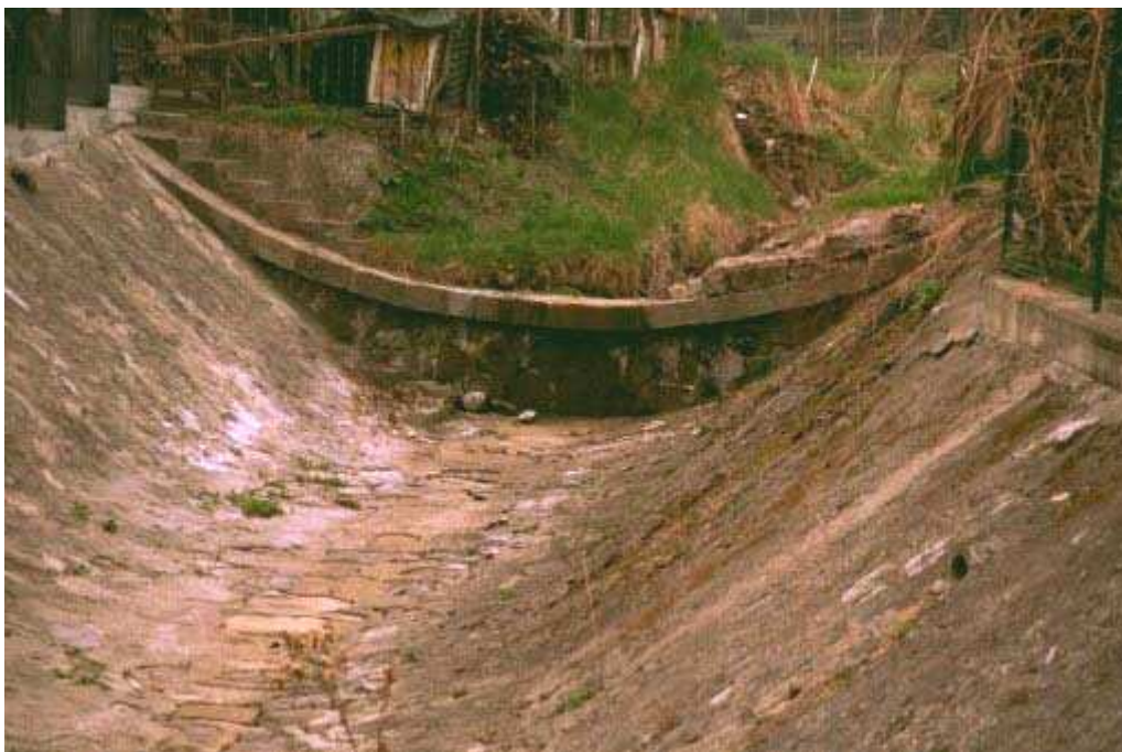
Foto 037 – Opera CANASO037 . Ripresa da valle verso monte.
