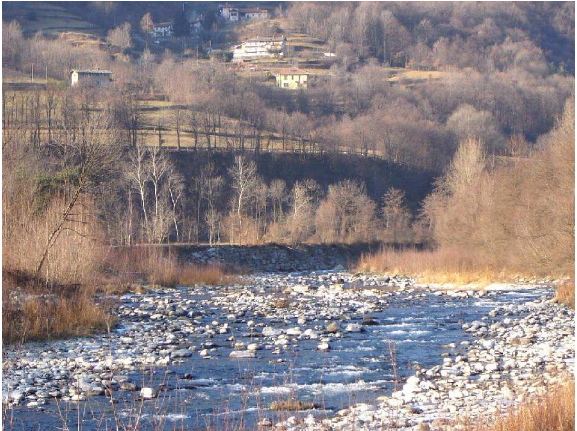
Foto 013 – Opera CANADS013 . Ripresa da valle, sponda sinistra del T. Chisone.
