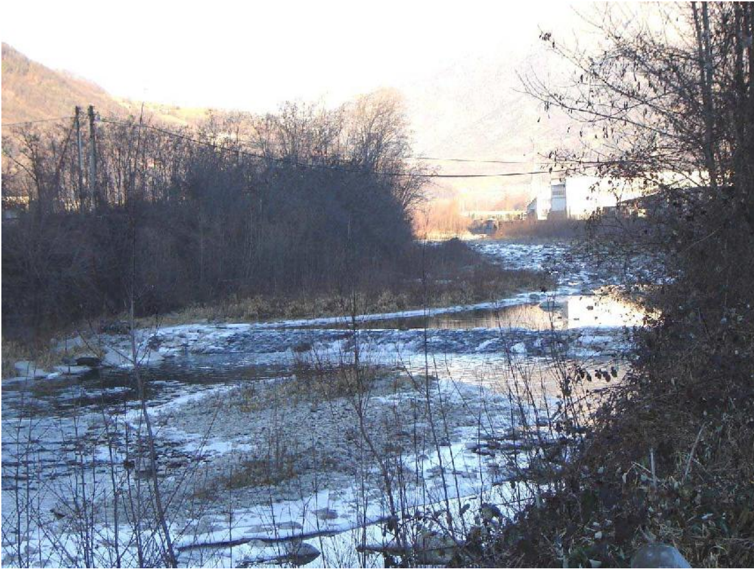
Foto 040 – Opera PENNSO040 . Ripresa da valle, sponda sinistra del T. Chisone.
