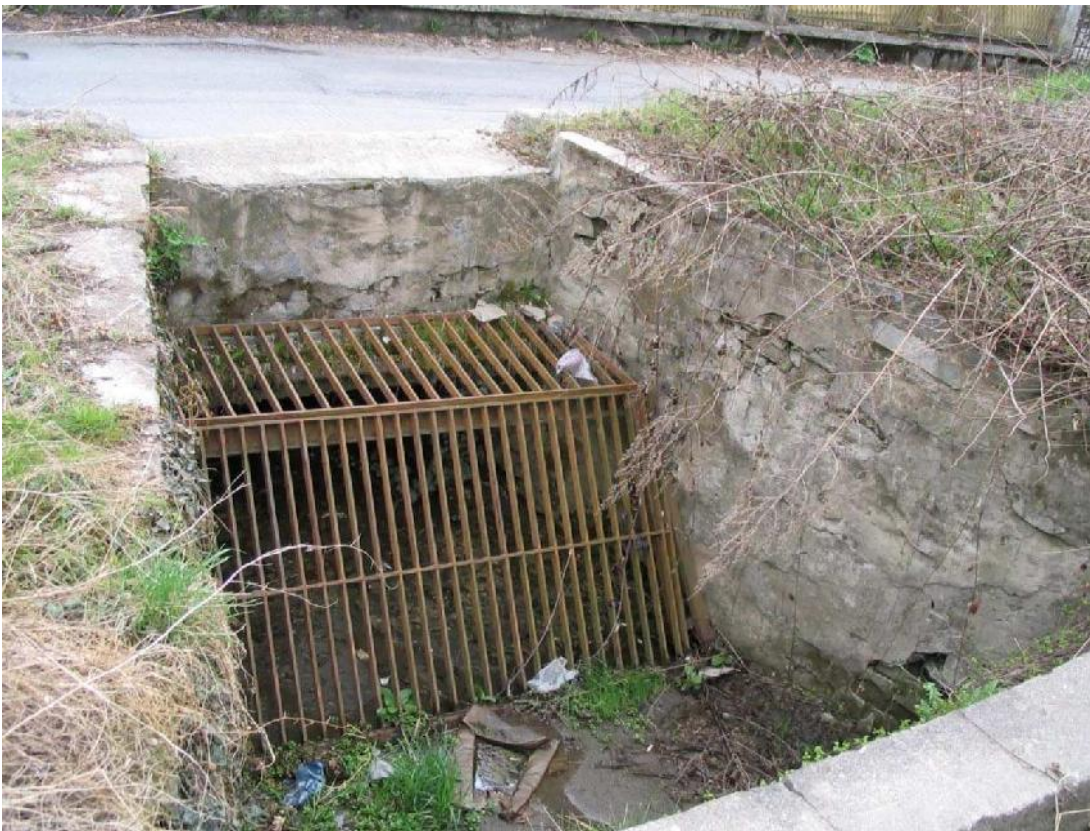
Foto 006 – Opera BATTCA006 . Ripresa da monte, sponda sinistra dell'impluvio.
