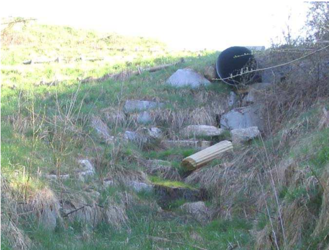
Foto 010 – Opera BATTCA010 . Ripresa da valle, allo sbocco nella Roggia Rifugi.
