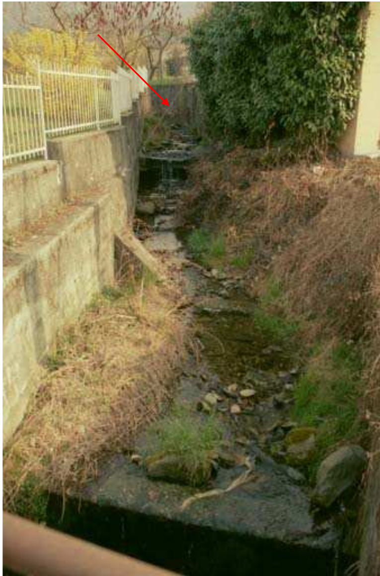
Foto 003 – Opera CANADS003 . Ripresa da valle verso monte.
