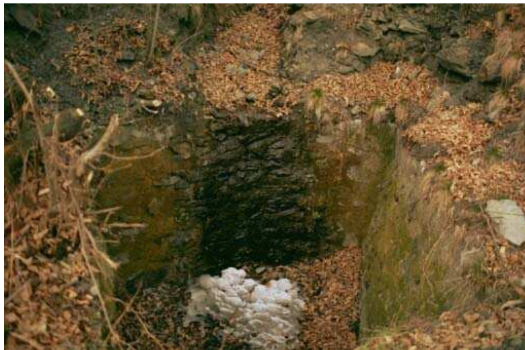
Foto 004 – Opera CANASO004 . Ripresa da valle verso monte.
