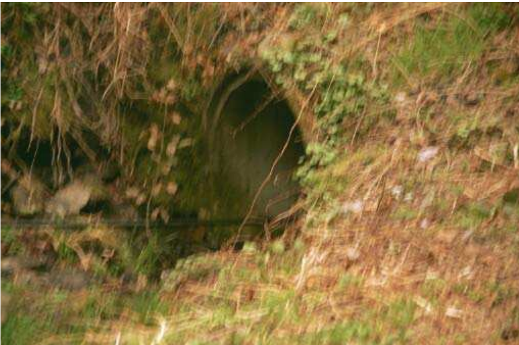
Foto 036 – Opera TREVAG038 . Ripresa laterale.
