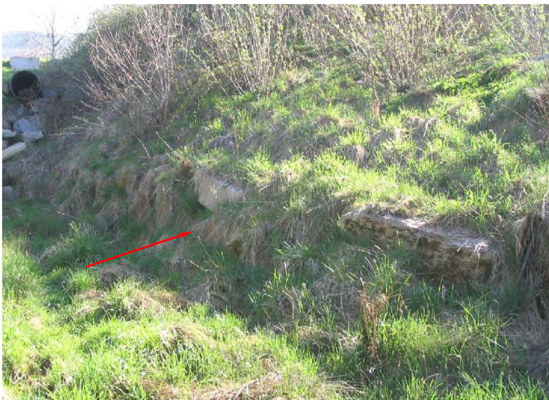
Foto 023 – Opera BATTDS023 . Ripresa da valle, sponda destra della Roggia Rifugi.
