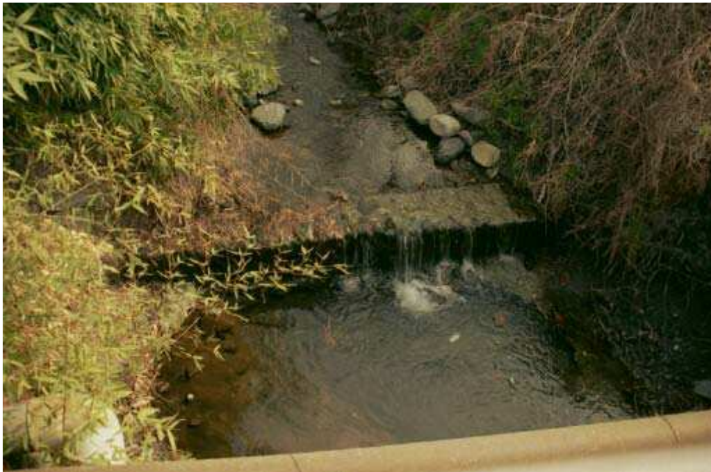
Foto 013 – Opera CANASO013 . Ripresa da valle verso monte.
