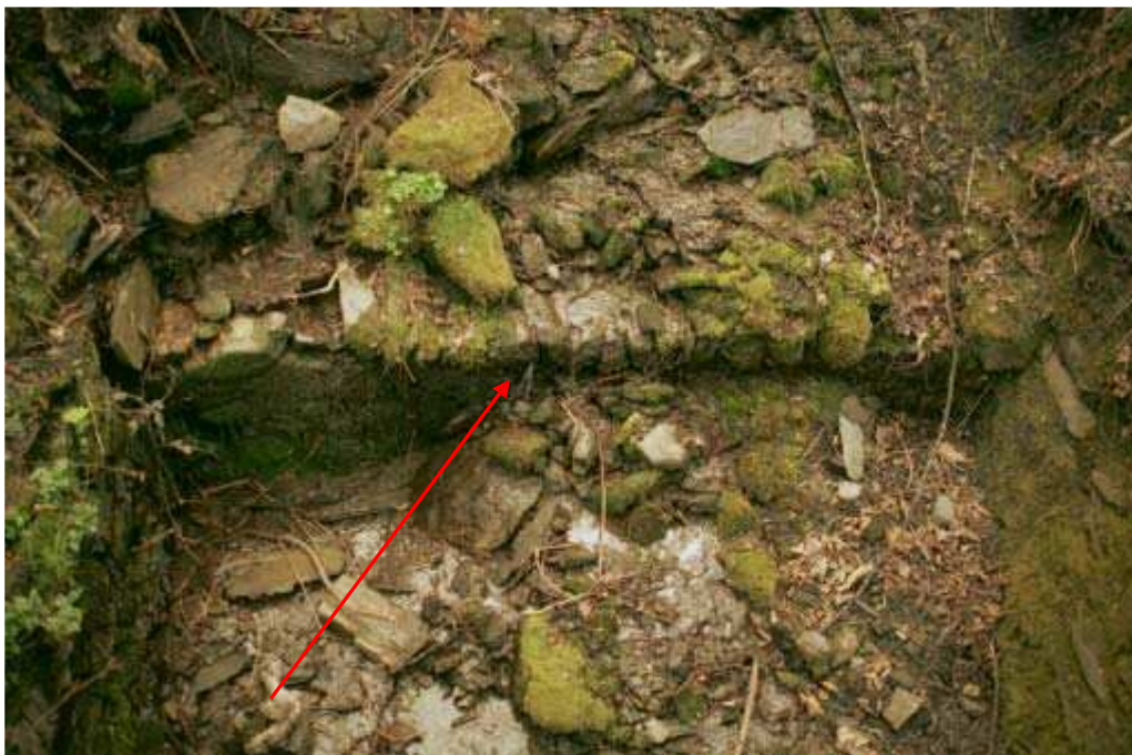
Foto 021 – Opera CANASO021 . Ripresa da valle verso monte.
