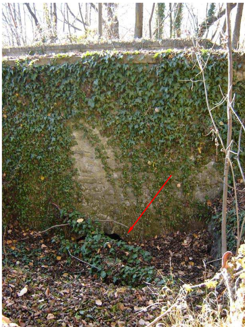
Foto 053 – Opera BATTAG055 . Ripresa da monte, sponda . destra del Rio La Rui.
