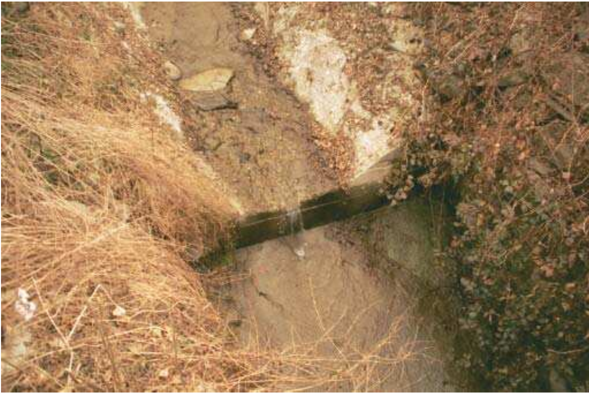
Foto 003 – Opera CANABR003 . Ripresa da valle verso monte.
