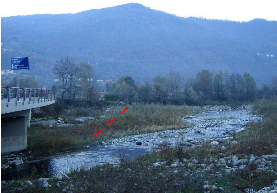
Foto 012 – Opera TREVDS012 . Ripresa da monte verso valle.
