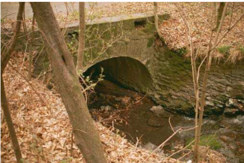
Foto 038 – Opera TREVAG040 . Ripresa da monte.
