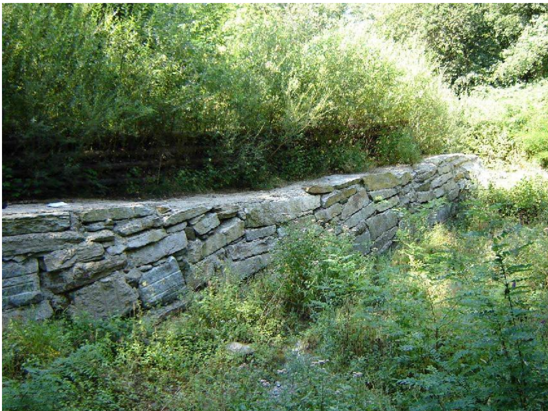
Foto 028 – Opera PENNDS028 . Ripresa da monte in alveo.
