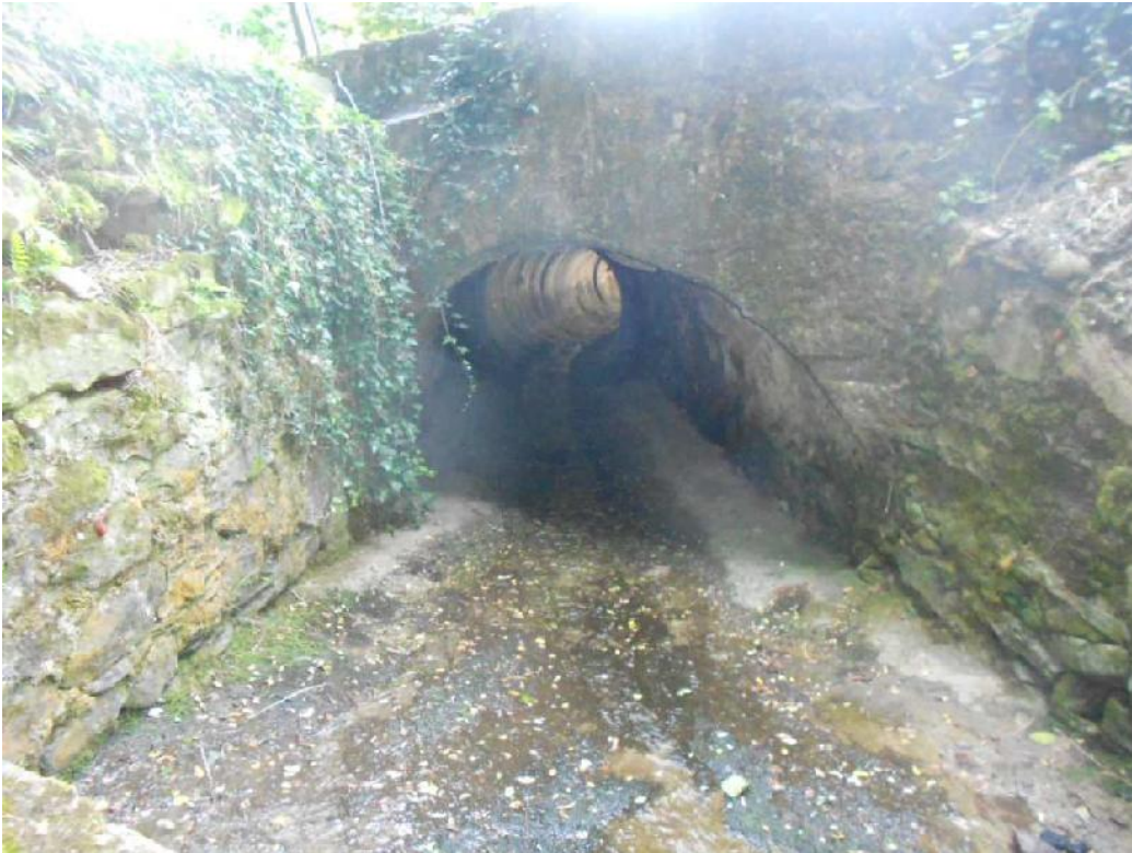
Foto 013 – Opera CASTCA016 . Ripresa dall'imbocco di monte.
