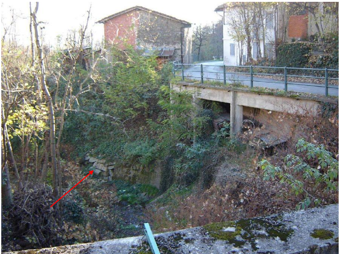
Foto 014 – Opera TREVDS008 . Ripresa da monte, dal ponte TREVPO006 .
