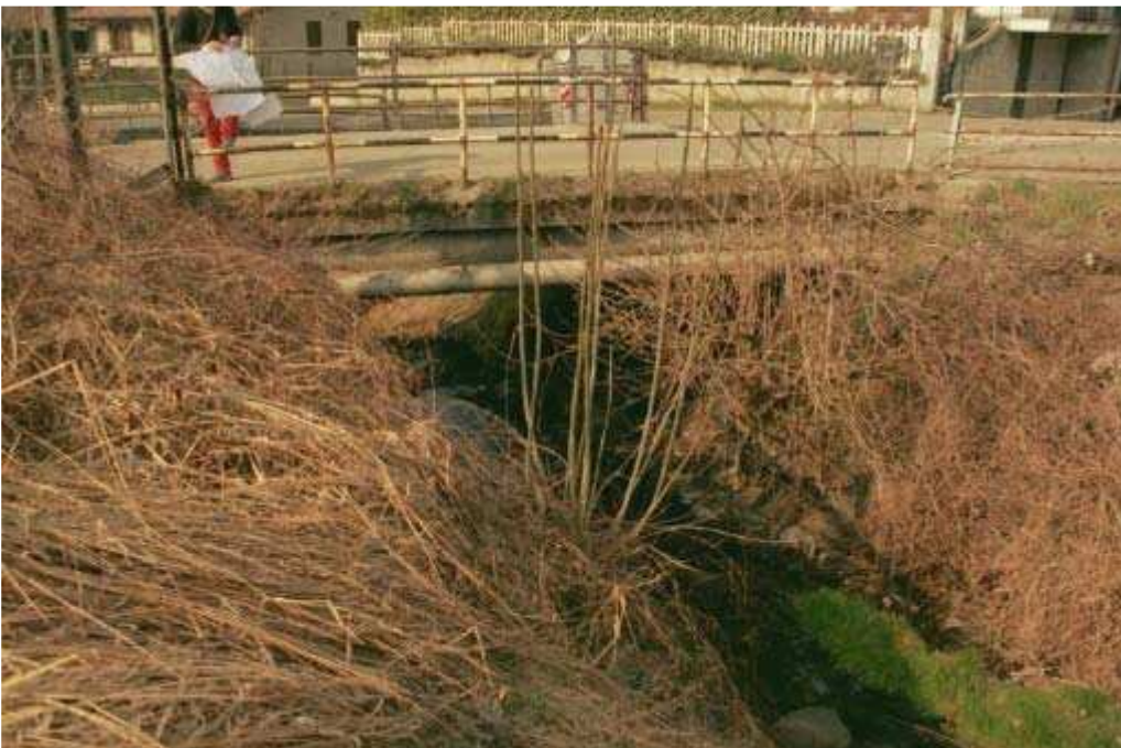
Foto 010 – Opera TREVAG010 . Ripresa da monte, sponda sinistra dell'impluvio.
