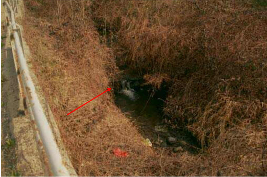
Foto 0010 – Opera TREVSO010 . Ripresa da valle verso monte.
