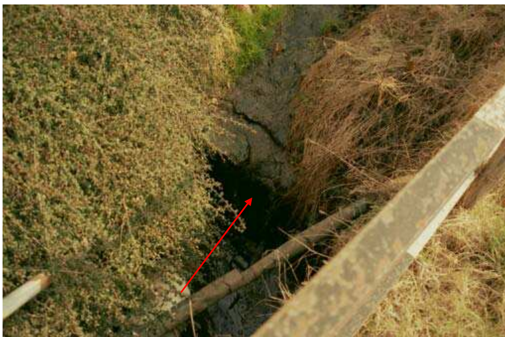
Foto 007 – Opera CANASO007 . Ripresa da valle verso monte.
