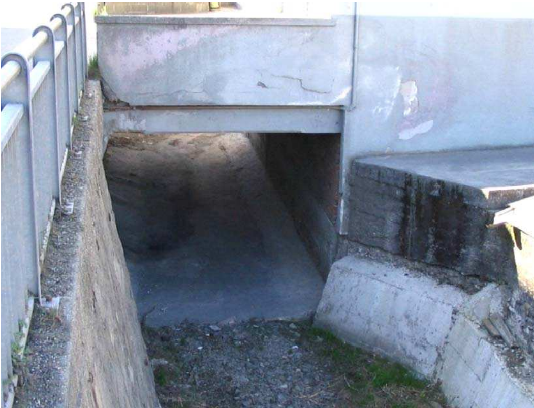
Foto 057 – Opera BATTAG059 . Ripresa da monte, sponda sinistra della canalizzazione CANAAG003.
