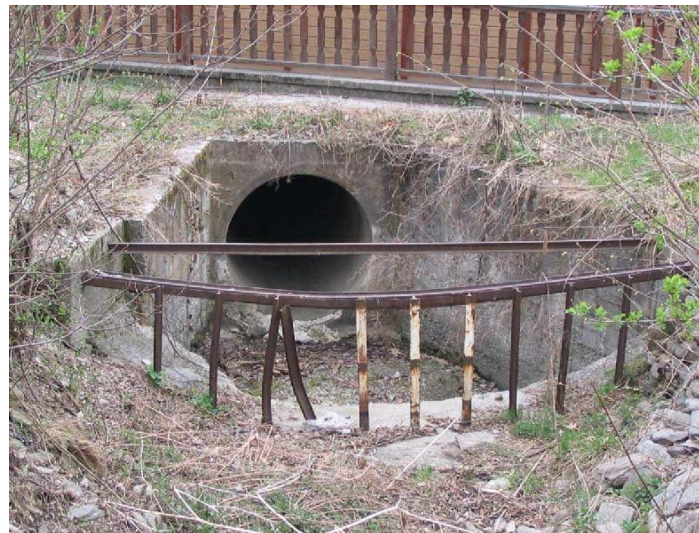
Foto 008 – Opera BATTCA008 . Ripresa da monte, dal greto dell'impluvio.
