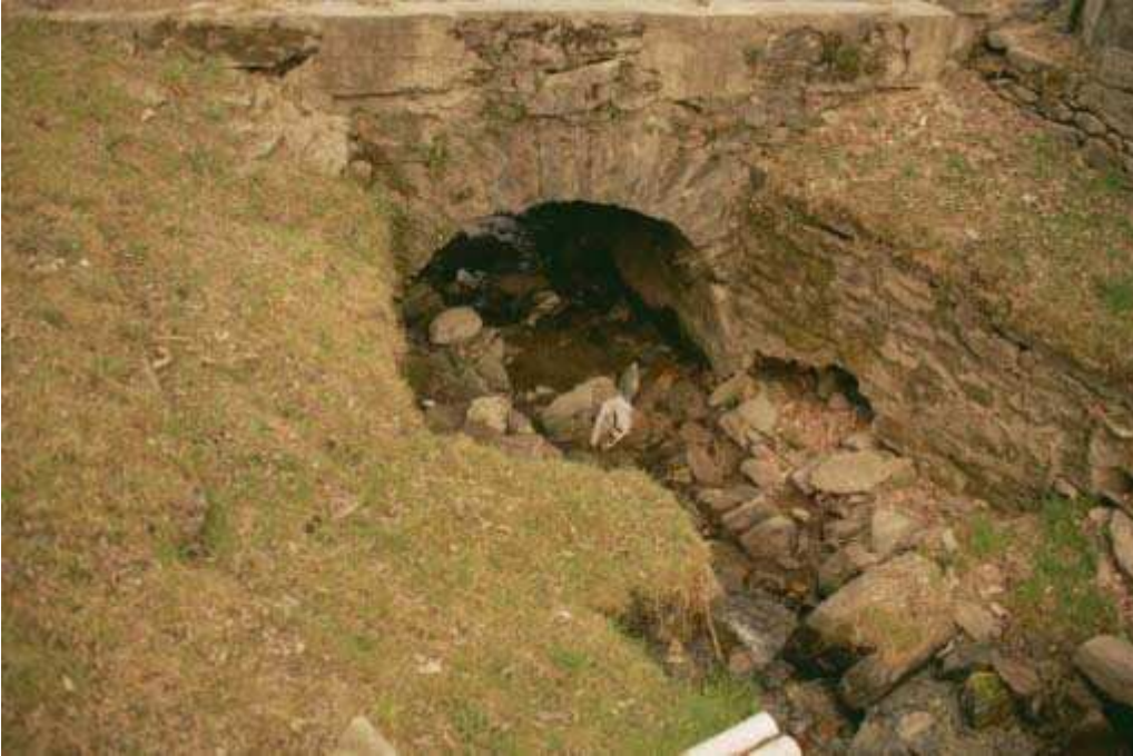
Foto 017 – Opera CANAAG017 . Ripresa da monte, sponda sinistra.
