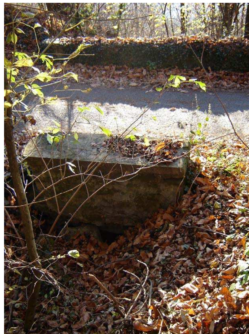
Foto 054 – Opera PENNAG056 . Ripresa da monte, sponda destra del Rio La Rui.
