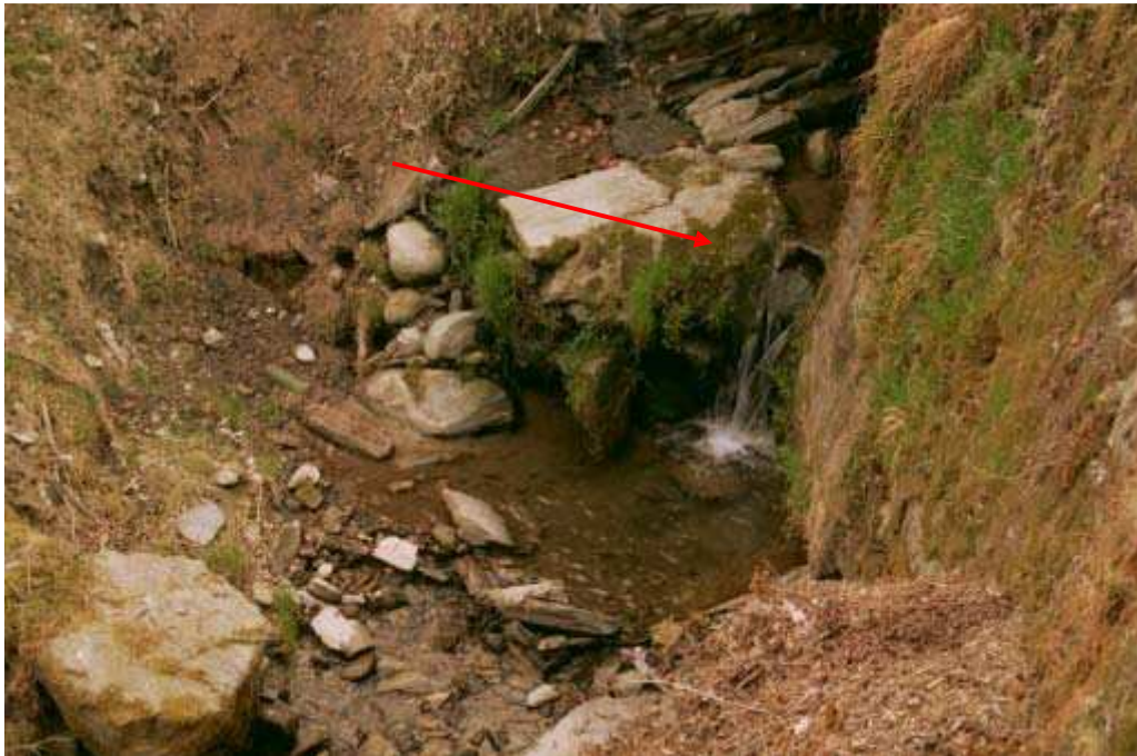
Foto 016 – Opera TREVSO016 . Ripresa da valle verso monte.
