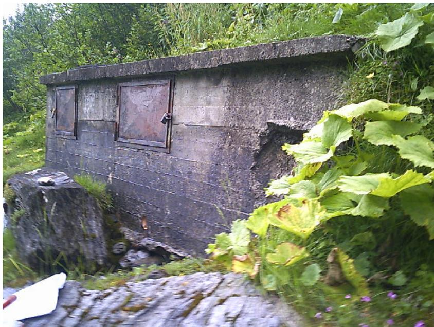
Fotografia 3.8. Bottino di presa sorgente *Eicafa* (S4) caratterizzata da evidente sifonamento delle acque di captazione sia sulla parete a sinistra che destra delle aperture.
