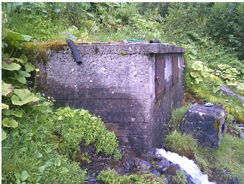
Fotografia 3.9. Bottino di presa sorgente *Eicafa* (S4) caratterizzata da evidente sifonamento delle acque di captazione sia sulla parete a sinistra che destra delle aperture.
